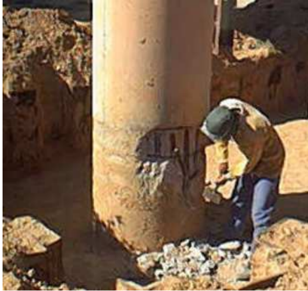
Figure 5.1 Piquage du béton
