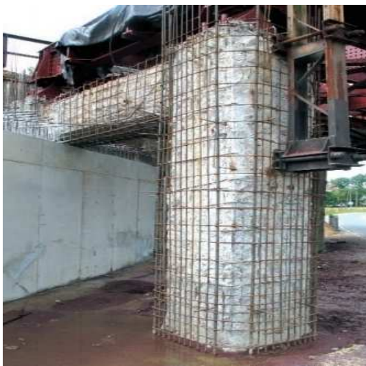
Figure 5.2 Traitement des armatures corrodées
