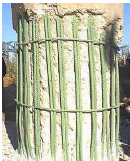
Figure 5.2 Traitement des armatures corrodées
