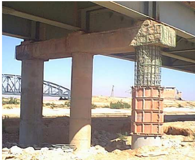
Figure 5.3 Renforcement des fûts dégradés
