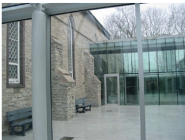
passerelle d'accès aux loges
