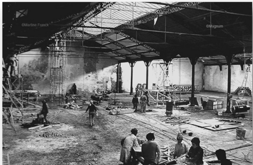
Figures représentent l'état du bâtiment 1
