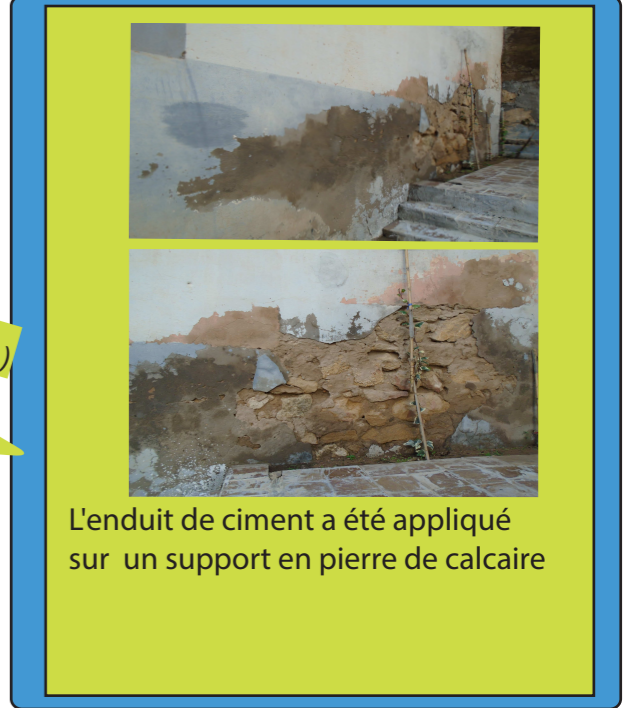
la peinture s'écaille avec un dépôt blanchâtre: salpêtre
