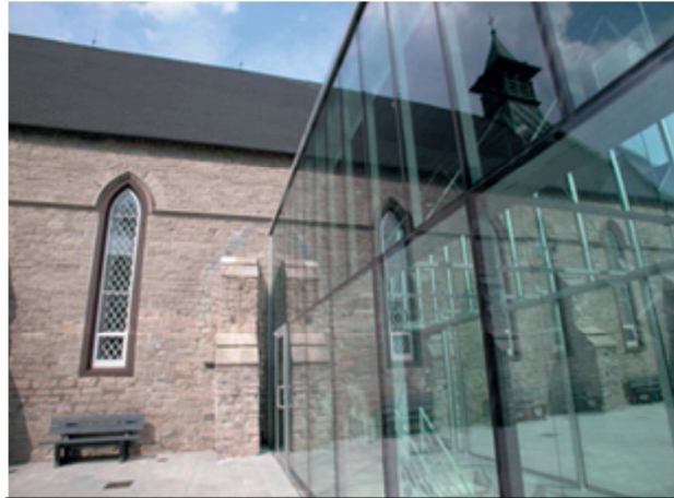
Le mur-rideau de verre et la cloison miroir (Source :Dan S. Hanganu Architectes).
