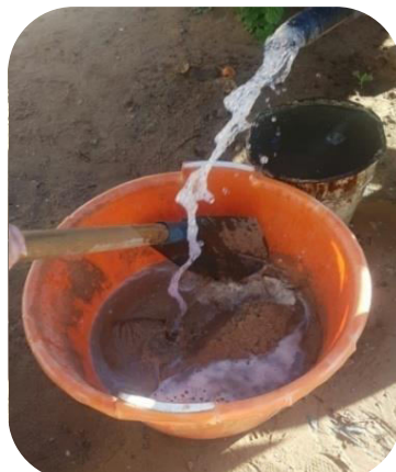
Fig. 16 : lavage du sable à l'eau ordinaire
