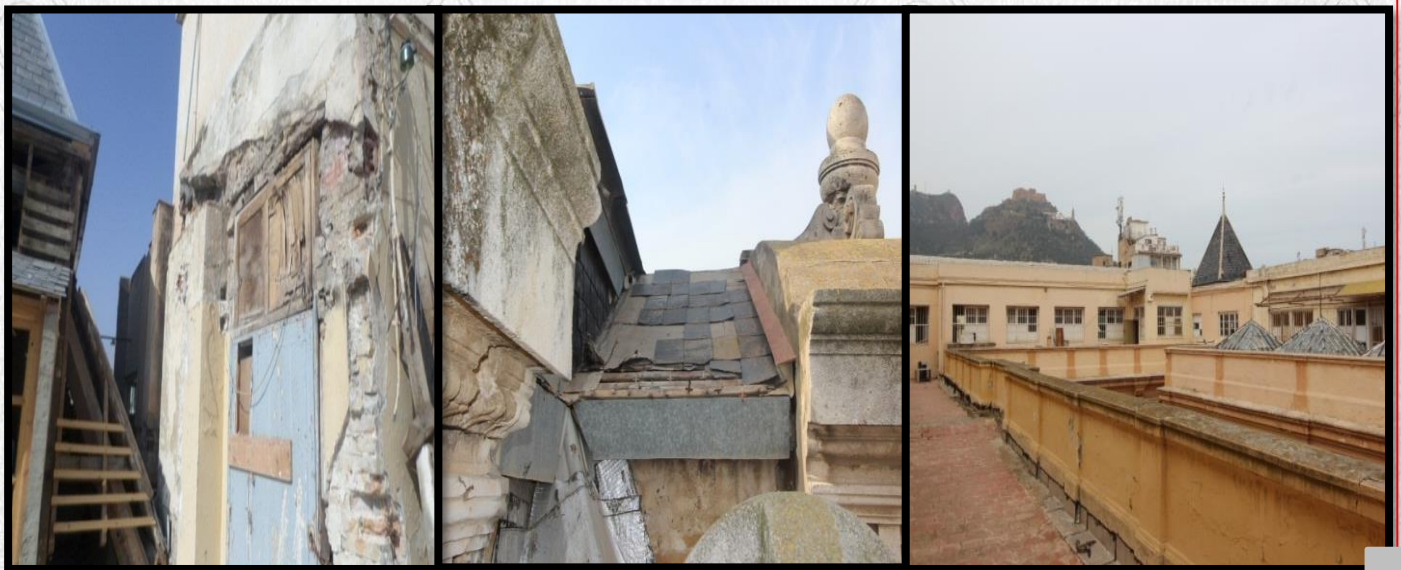
Figure 88 : Photos de la terrasse et toiture de l'hôtel de ville Source : Auteur
