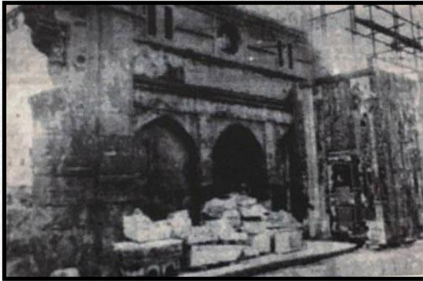
Figure 79 : Etat du Pavillon d'entrée a la suite de l'incendie en 1883 Source : Archives d'Oran, APC
