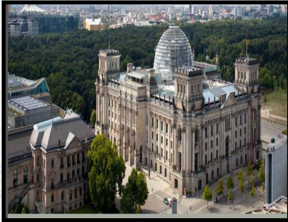
Figure 102 : Photos du bâtiment du Reichstag Source : Google
