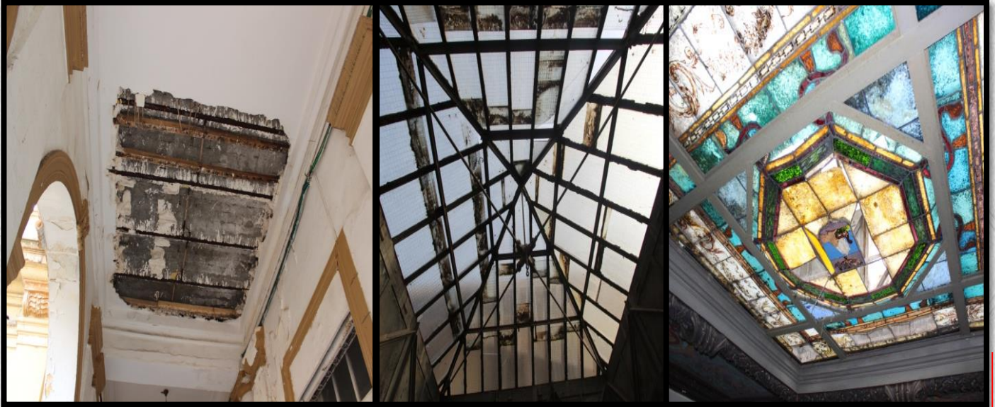
Figure 87 : Photos de la cage d'escalier de l'hôtel de ville Source : Auteur
