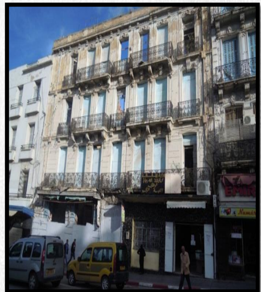
Figure 47 : photo d'un immeuble. Source : Auteur
