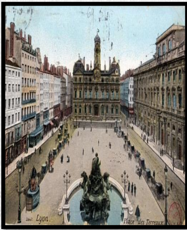
Figure 68 : Photos de la Place des terreaux Source : Google
