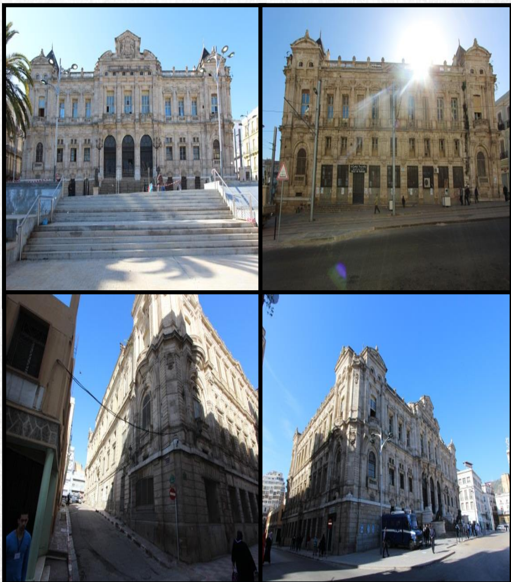
Figure 86 : Photos des façades de l'hôtel de ville Source : Auteur
