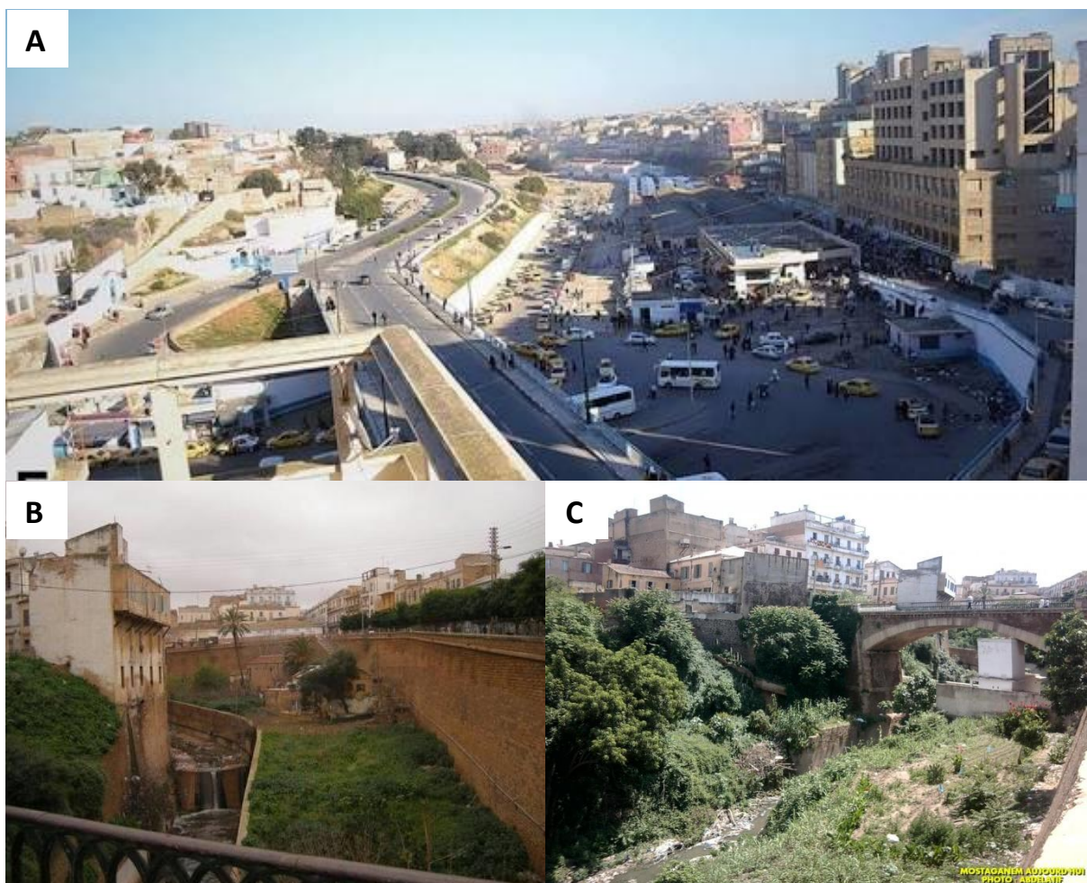
Figure 18- L'état actuel du ravin de Aïn Sefra : (a) une vue sur le site des trois ponts, (b) et (c) les déchets jetés dans le ravin (Source: archives de presse).
