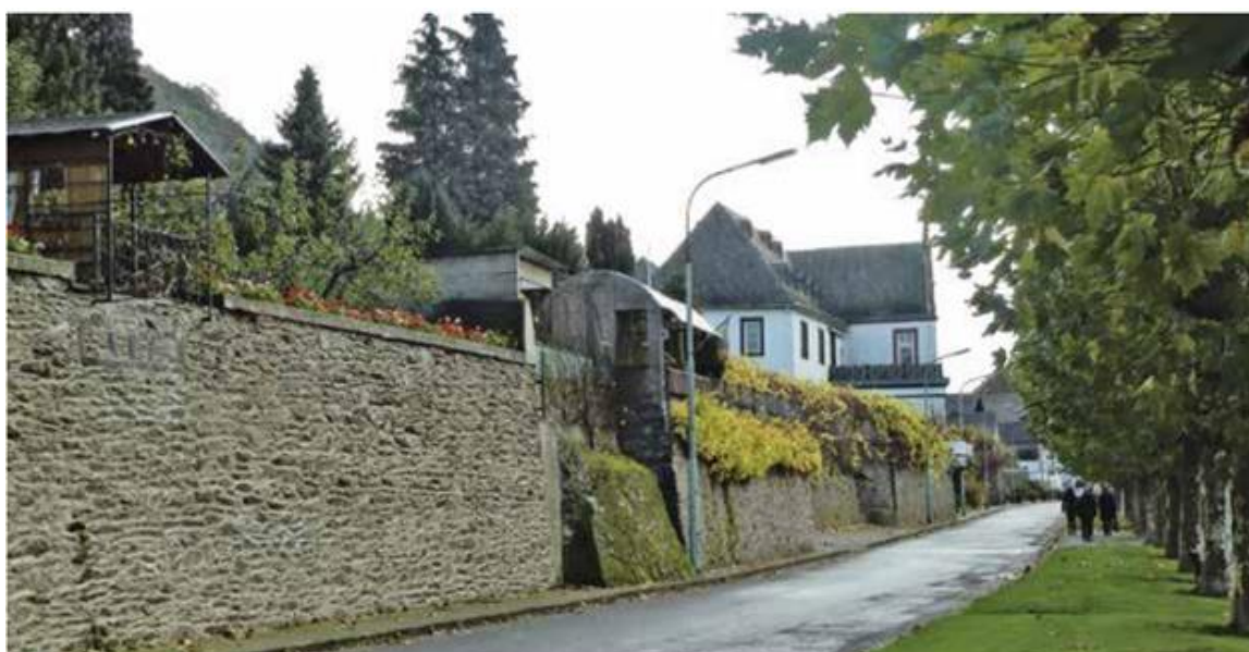
Figure 21 : Mur de protection contre les crues du Rhin, à Leutesdorf (Allemagne) [11].
