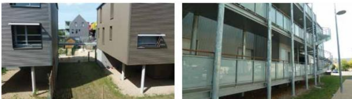
Figure 46 : Exemples de maisons individuelles et immeubles sur pilotis à Saint-Pierre-des-Corps [11].
