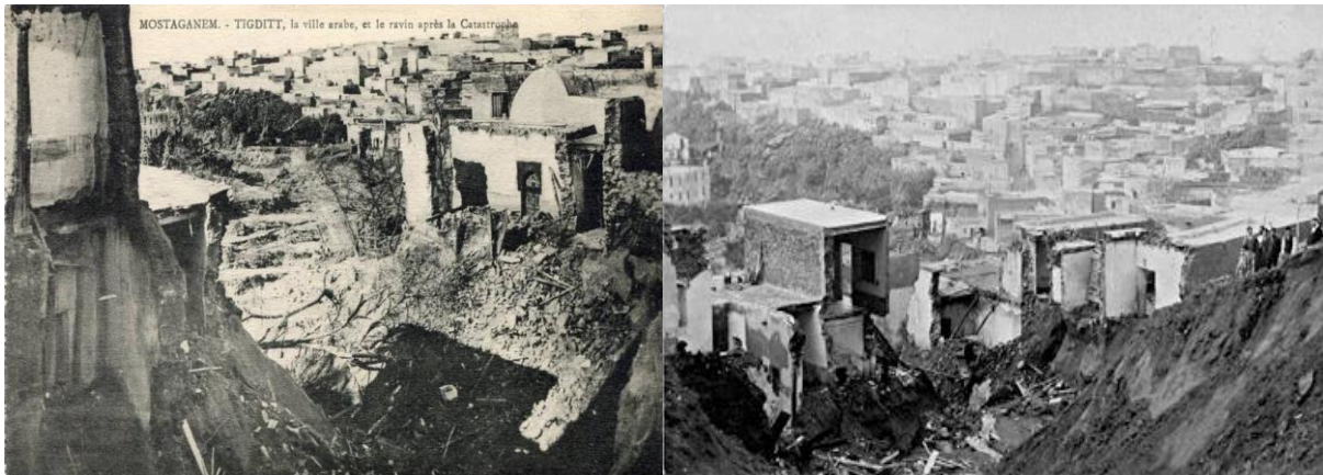
Figure 16- Vue sur Tigditt après la catastrophe (Source: photos d'archives).
