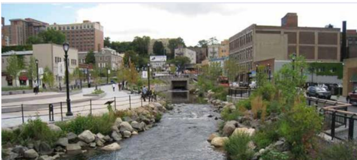
Figure 41 : La rivière Saw Mill après sa remise à ciel ouvert à Larkin Plaza, Yonkers. Source: Groundwork Hudson Valley.
