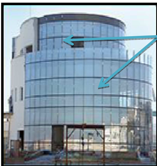
Façade vitrée (La transparence)
