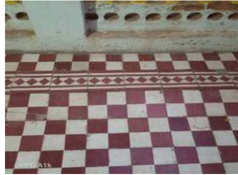
photo c-05 : le revêtement du sol
