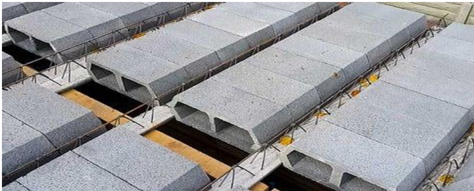
Figure 4 : Plancher à corps creux (source : www.udemy.com )
