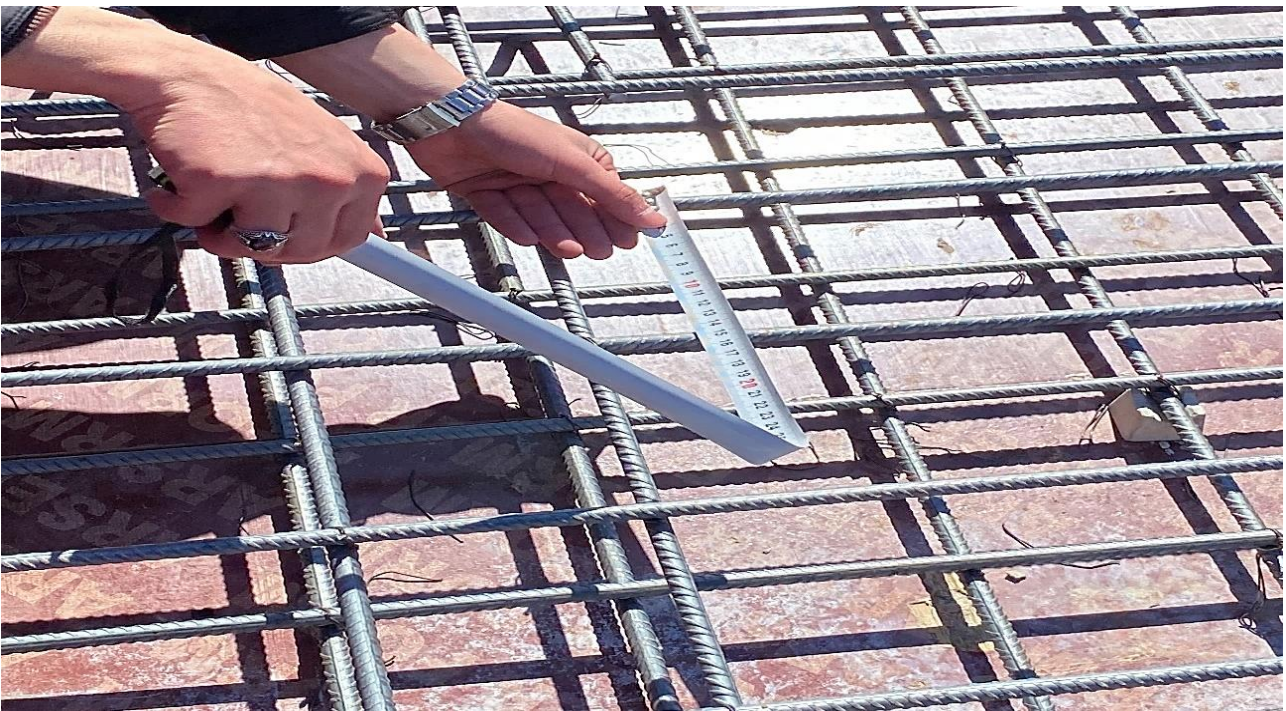
Figure 32 : Photo réelle d'un espacement des armatures fixé à 15 cm (imoja sig).
