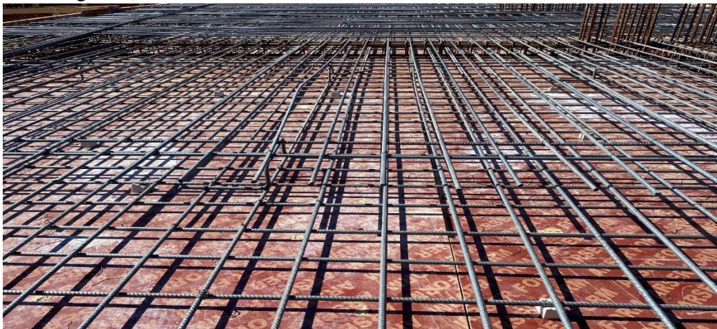
Figure 5: Ferrailage de dalle pleine (imoga sig).
