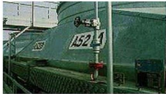
Figure III.9 : Boîte de distribution à bouchons dévissables
