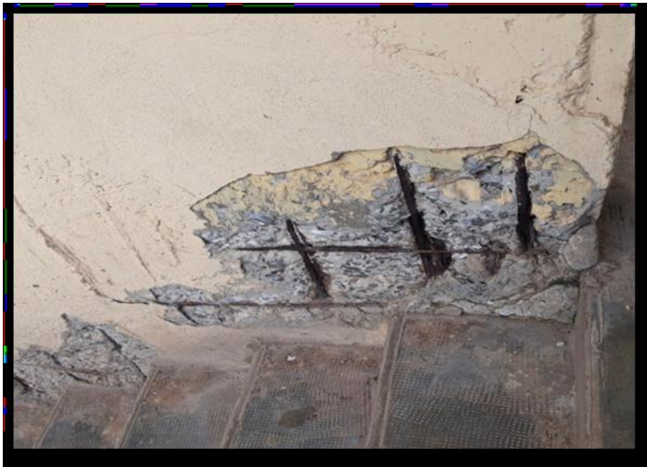
Figure III-6 : Corrosion des aciers dans le béton.
