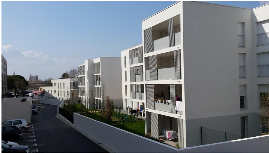
Figure 20 : Quartier après l'intervention
