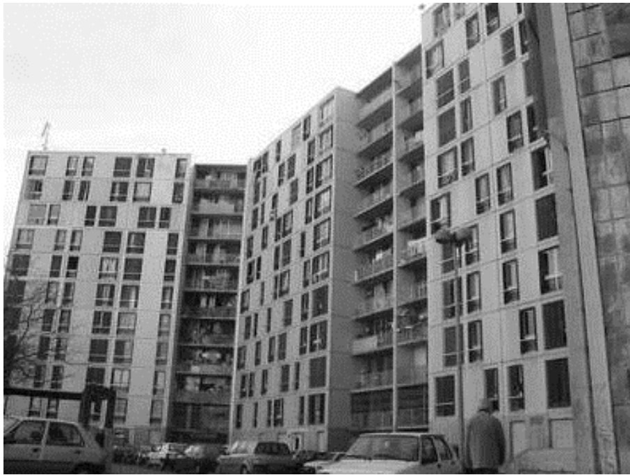
Figure 18 : Quartier avant l'intervention
