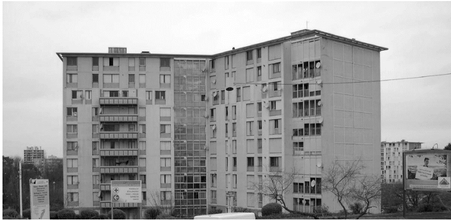
Figure 19 : Quartier avant l'intervention
