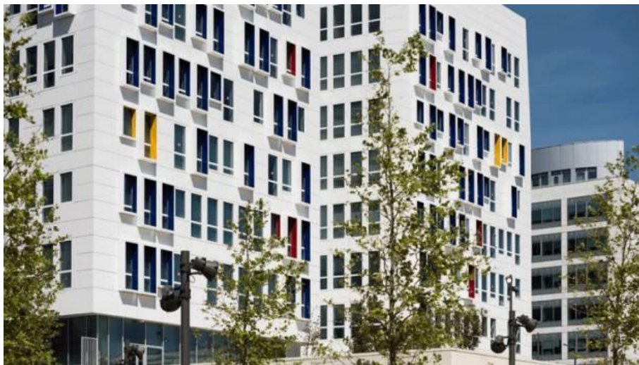
Figure 21 : Quartier après l'intervention
