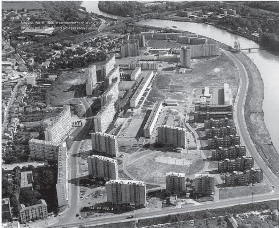
Figure 31 : Cartier d'Empalot avant
