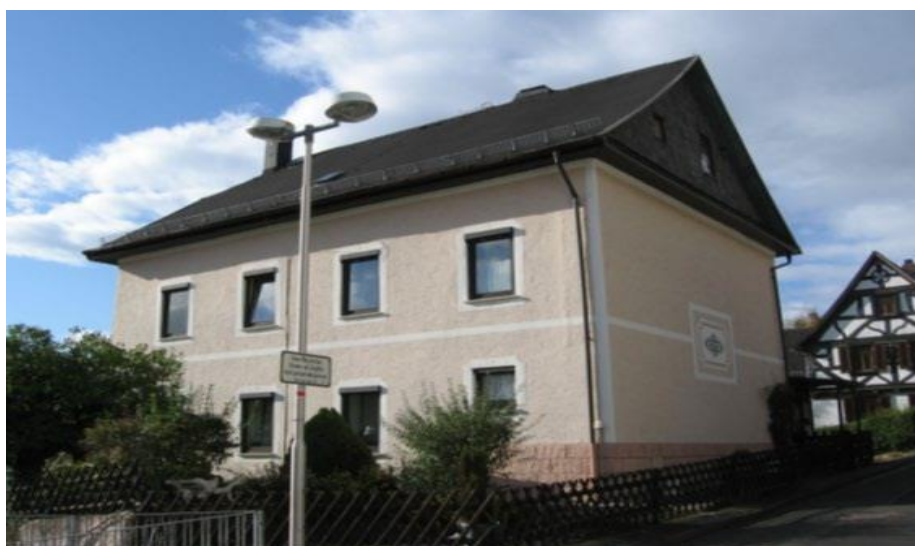
Figure II-6: Une école construite en pisé à Bonbaden, (en Allemagne)
