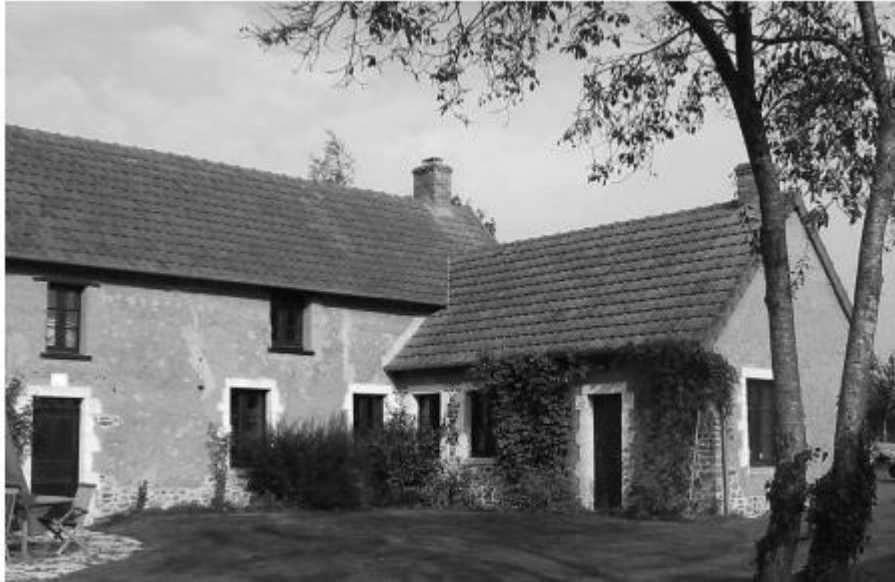
Figure II-9: Habitation contemporaine en bauge à Marchésieux, Manche (C.-A. de Chazelles)
