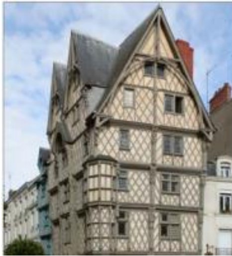
Figure II-8: Une construction en torchis à Angers, France.
