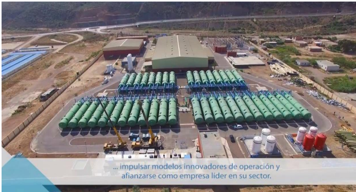
Figure I.1 : La station de dessalement d'eau de mer de Mostaganem.
