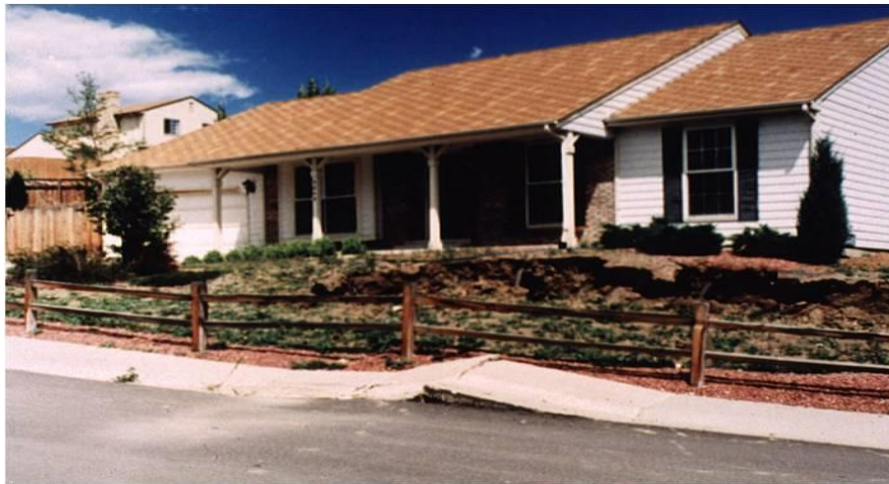
Figure 1.2 gonflement du sol provoquant des dommages du trottoir ainsi que l'habitation
