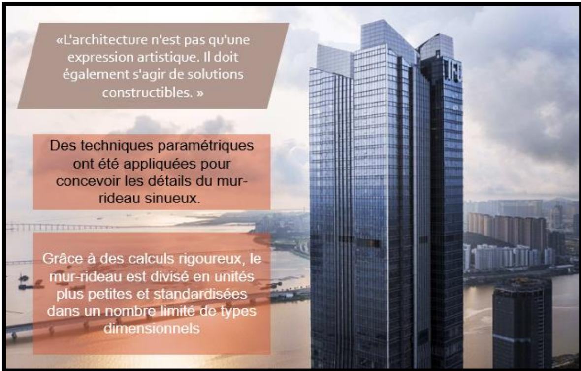
Figure : détails de façade du projet.
