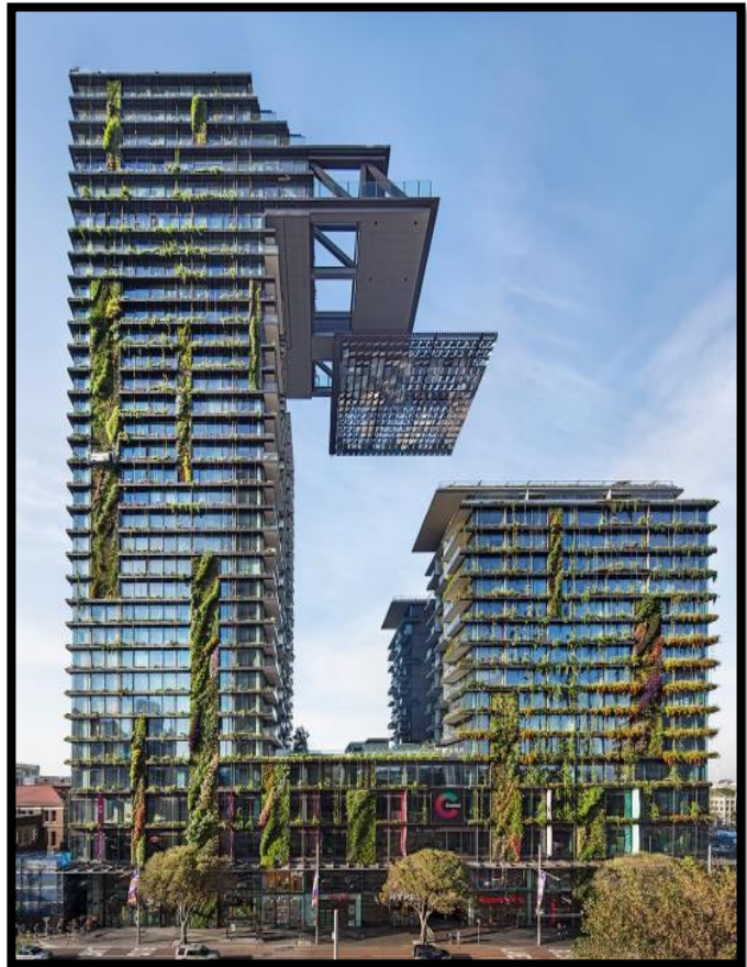
Figure : Vue sur la façade végétalisée de One Central Park
