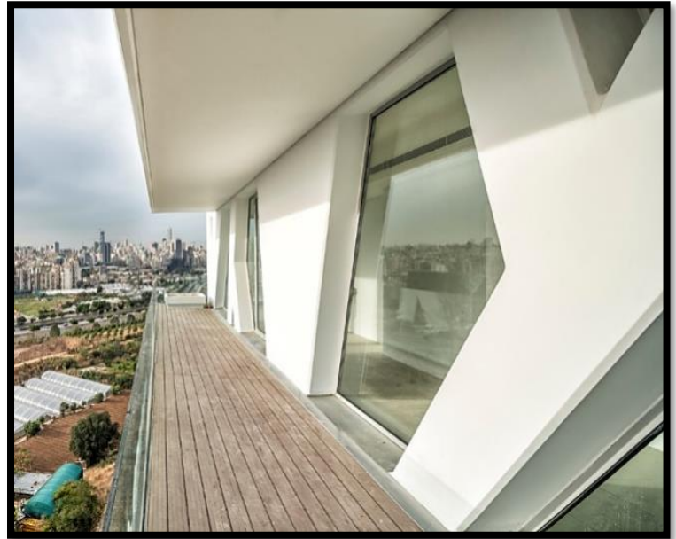
Figure : Balcon de la tour
