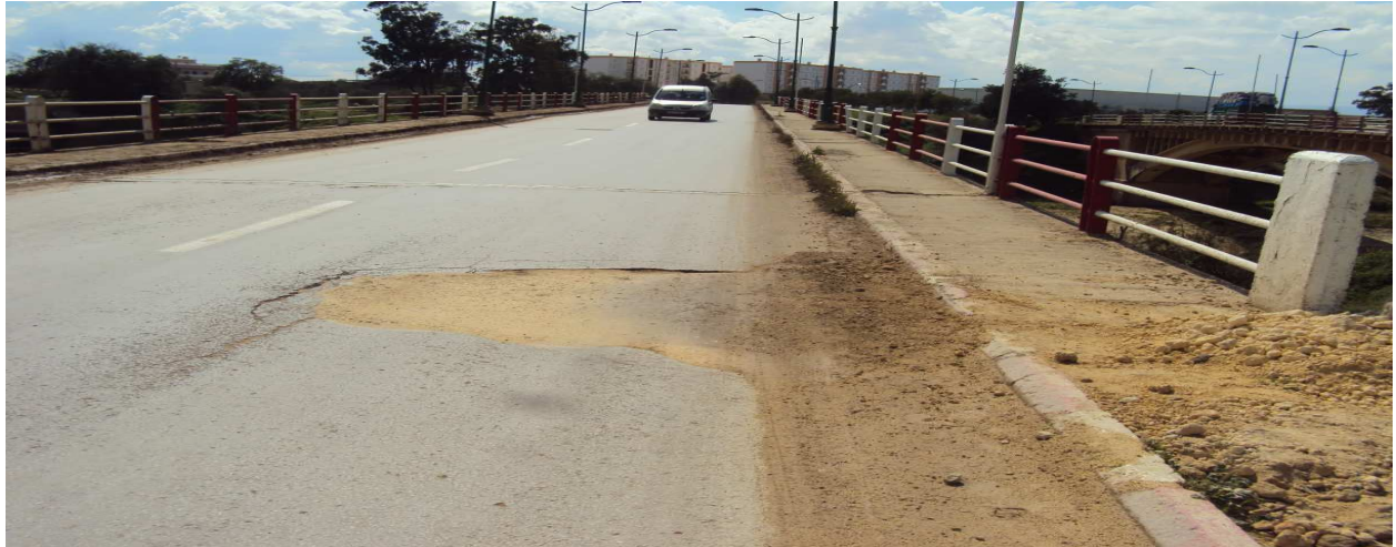
Fig. 1. 3 dégradations en forme de nid-de-poule (la chaussée de pont de Mina Wilaya de Relizane )
