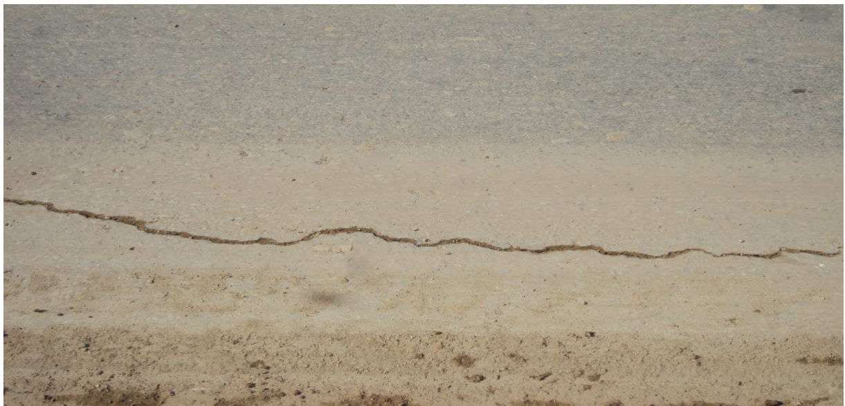
Fig. 1. 4 fissurations longitudinales de la couche de roulement (la chaussée de pont de Mina Wilaya de Relizane)
