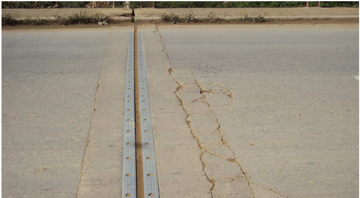
Fig. 1. 5 dégradation du au mauvais collage entre le béton de joint et la couche de roulement (la chaussée de pont de Mina Wilaya de Relizane)
