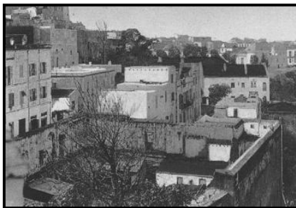
Figure 11: Palais du Bey hier 18
