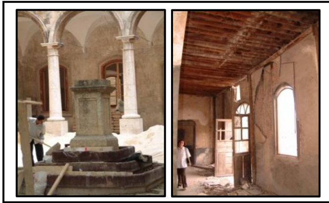
Figure 77: les travaux de reconversion de l'école Shibani . 93
