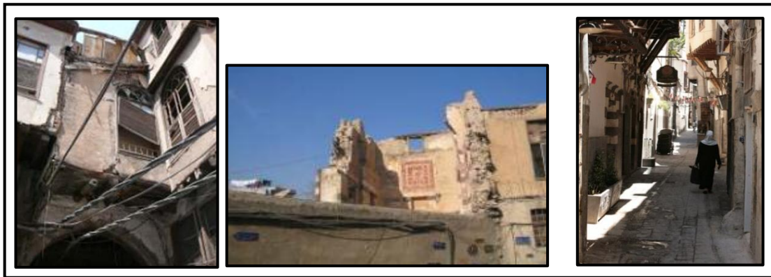
Figure 53: L'état actuel des constructions et ruelles de Damas. 83
