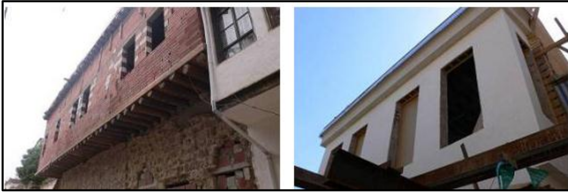
Figure 64: Restauration de la maison "Beit Nizam". 89
