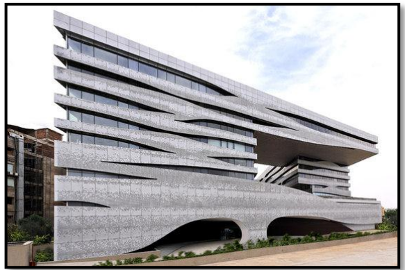
Figure 167: Aura spa (vue d'extérieur) 135
