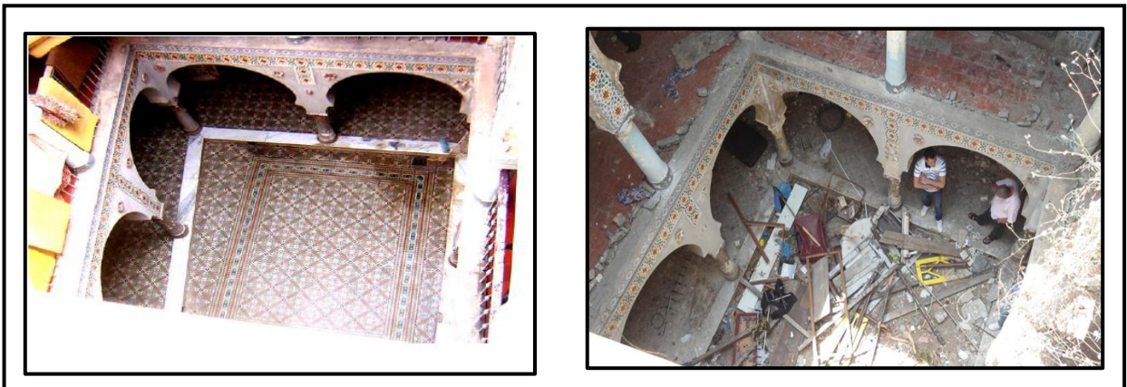
Figure 42: dar Hamid elAbd 2005 et après la destruction 2013 72
