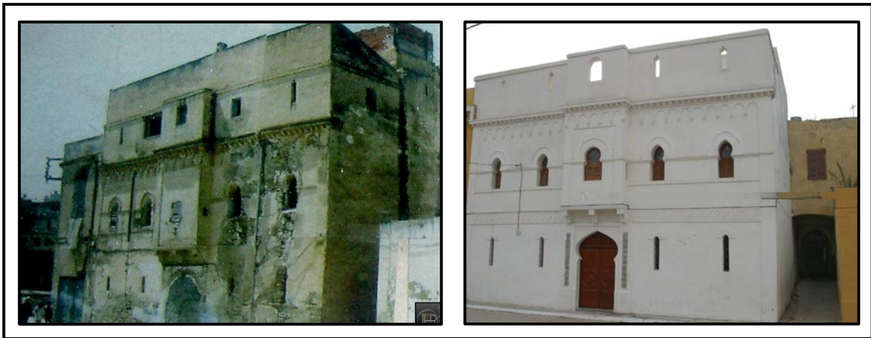
Figure 39: Dar El-kaid avant et après la restauration 66
