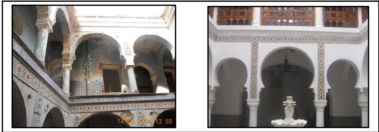
Figure 49: vue de l'intérieur de dar Hamid el-Abd (après la destruction) et dar El-Kaid (après la restauration) 80
