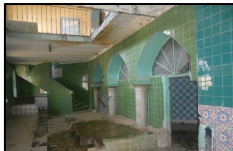
Figure 108: Les murs intérieurs 107
