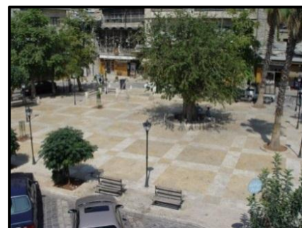
Figure 82: La place après la restauration. 94
