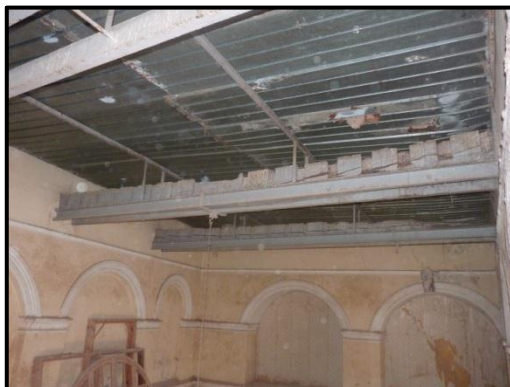
Figure 143: Le plancher (profilés métalliques) 120
