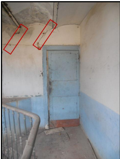
Figure 128: Cage d'escalier (bain maure) 113
