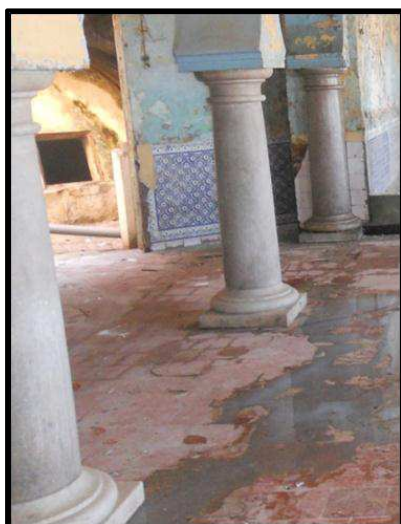
Figure 119: La chambre froide (étage) 109
