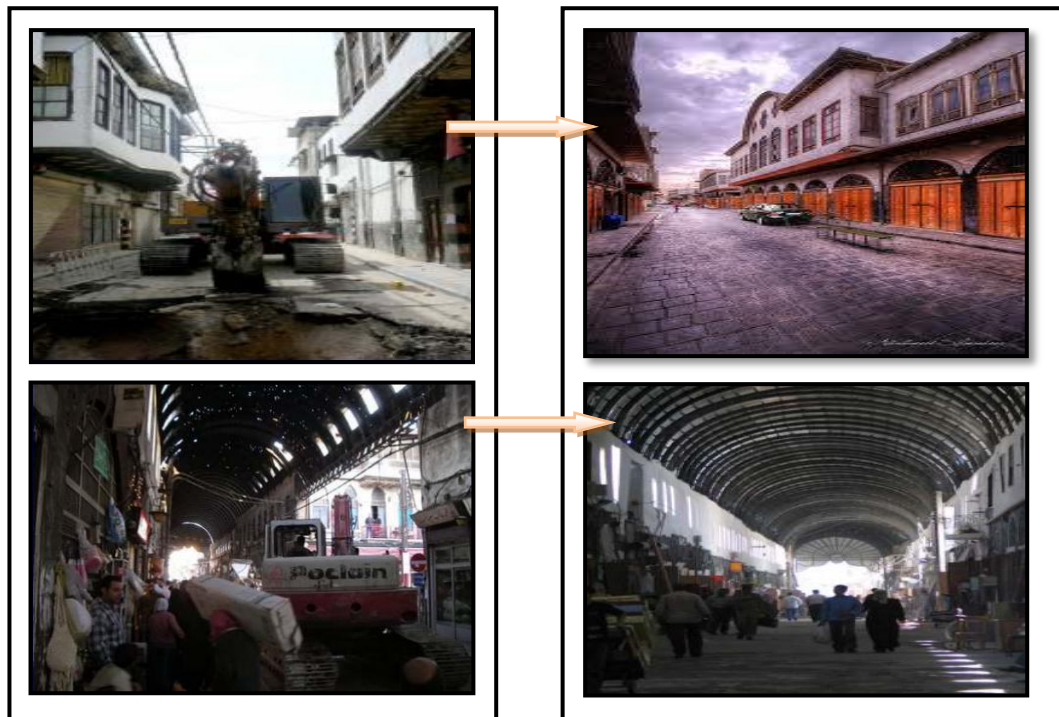
Figure 56: les travaux effectués à Damas 85
