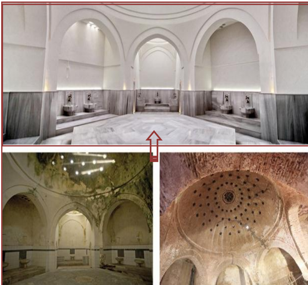
Figure 156: La restauration de la salle chaude 129
