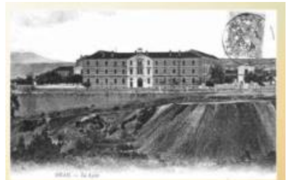
Les travaux de remblai Viennent à Encore commencés
