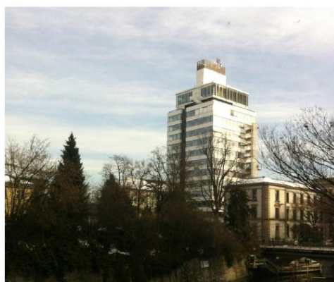
Surélévation d'une ancienne halle de dépôt par Fischer & Visini Architekten
