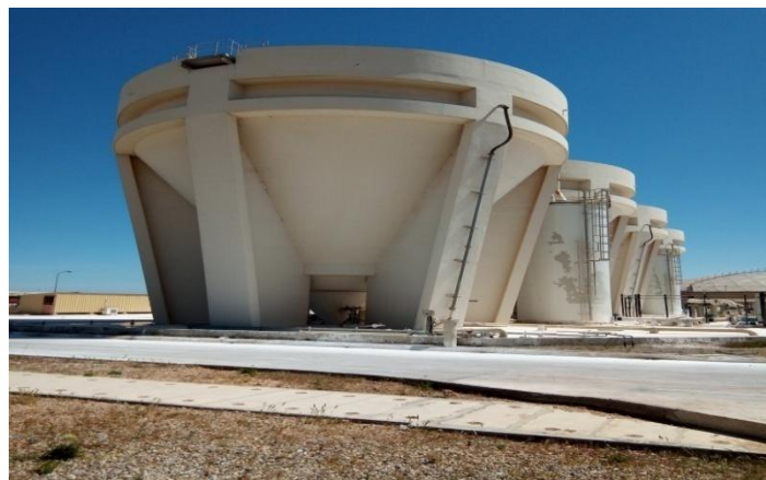
Fig. 20: Site de préparation de la chaux.
