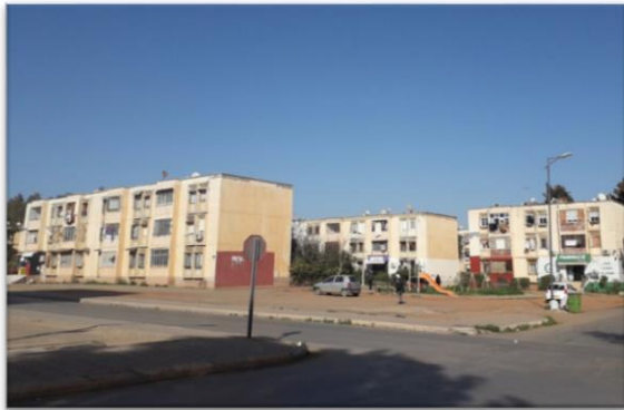
Figure 10 : la cité 800 logements
