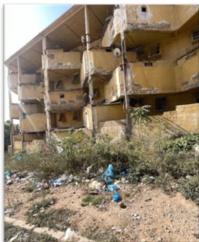
Figure 30 : Façade latérale du bloc 1.
