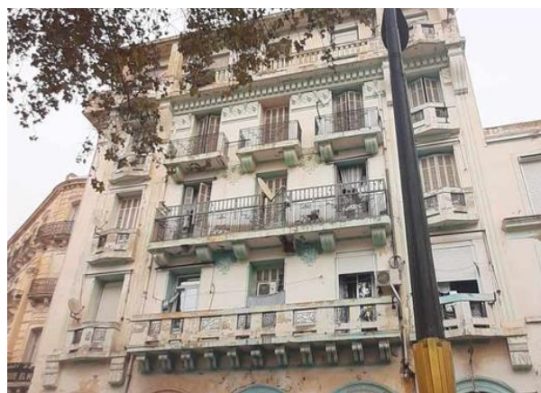
Figure 08 : bâtiment HBM Centre-Ville
