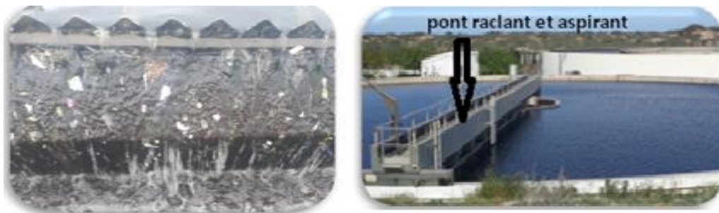
Figure n° III.10 : clarificateur de la step cap falcon
