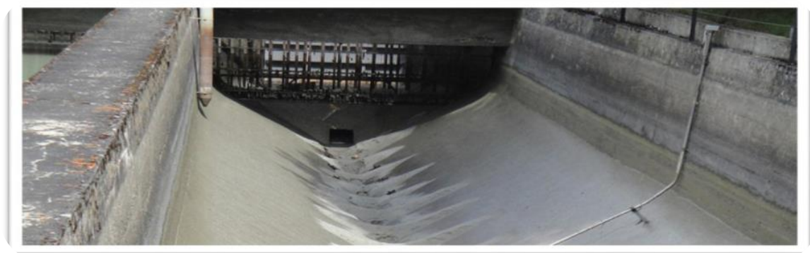
Figure n° II . 3: Photo d'un dessableur rectangulaire .
