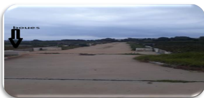
Figure n° III.12 : lits de séchages de la step cap falcon
