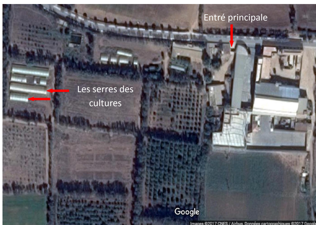
Figure 15: Vue aérienne de la station expérimentale de l'Université de Mostaganem (Google Earth, 2017).
