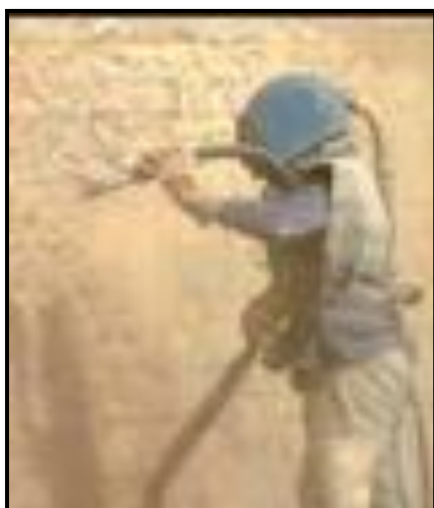
Fig. 2-77 : Nettoyage par Sablage 46
