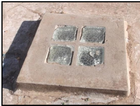
Fig. 2-30/2-31 : Dégradation du système d'aération et d'éclairage sur la terrasse de hammam Es-Sbaâ auteur du mémoire
