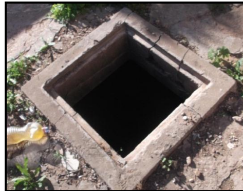
Fig. 2-30/2-31 : Dégradation du système d'aération et d'éclairage sur la terrasse de hammam Es-Sbaâ auteur du mémoire
