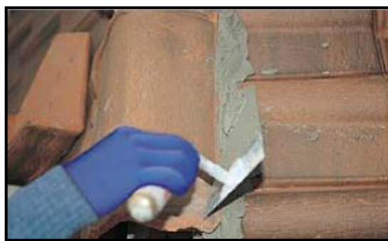
Fig. 2-61/2-62 : Nettoyage et remplacement des tuiles 38
