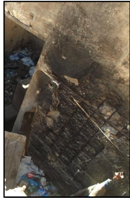
Fig. 2-24 : Vue sur la partie renforcée par le chemisage auteur du mémoire
