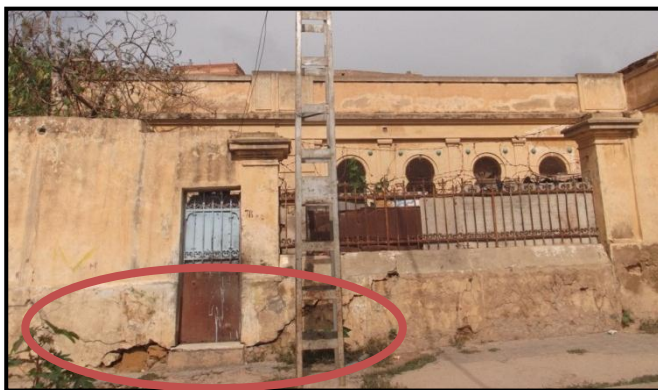
Fig. 2-16 /2-17 : Fissures apparentes sur le mur et l'enduit de hammam Es-Sbaâ auteur du mémoire
