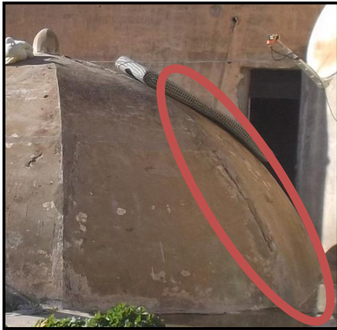
Fig. 2-36 : Fissure avec profondeur importante auteur du mémoire
