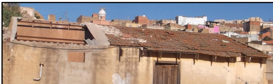
Fig. 2-32 : Toiture en tuile de hammam Es-Sbaâ auteur du mémoire
