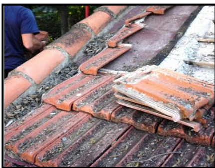
Fig. 2-61/2-62 : Nettoyage et remplacement des tuiles 38
