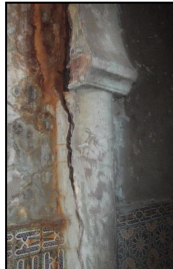
Fig. 2-26/2-27 : Demi-colonnes en pierre taillée avec des armatures auteur du mémoire
