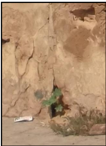
Fig. 2-22 : Prolifération de la végétation et les épaufreures auteur du mémoire
