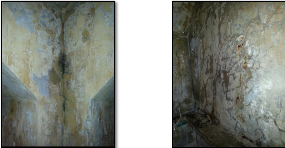
Fig. 2-73/2-74 : Vues sur le phénomène de condensation auteur du mémoire
