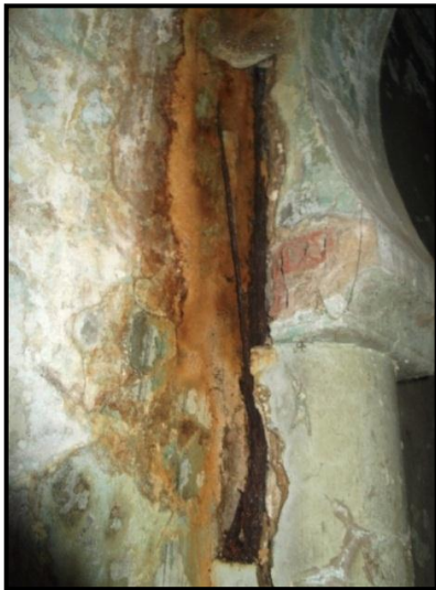
Fig. 2-26/2-27 : Demi-colonnes en pierre taillée avec des armatures auteur du mémoire
