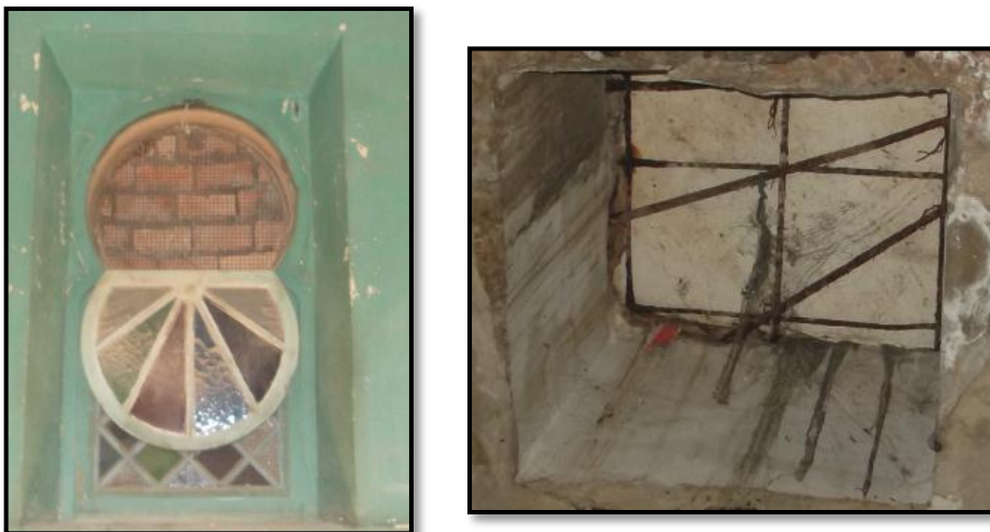
Fig. 2-75 : Fenêtre et puits d'aération au niveau du toit de Hammam Es-Sbaâ auteur du mémoire
