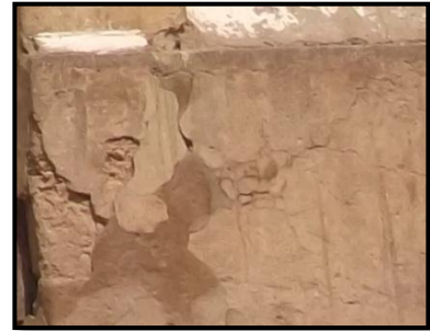
Fig. 2-45 : Apparition des tâches auteur du mémoire
