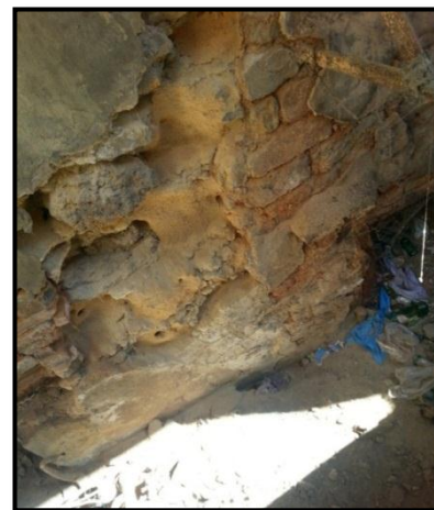
Fig. 2-25 : Le soubassement est le point faible de la maçonnerie auteur du mémoire
