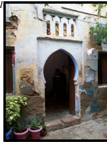
Fig. 2-8 : Porte d'une pièce de la maison type 1 1 auteur du mémoire
