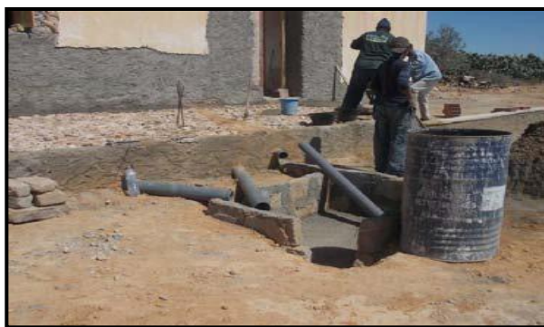
Fig. 2-85 : Installation des canalisations des eaux usées
