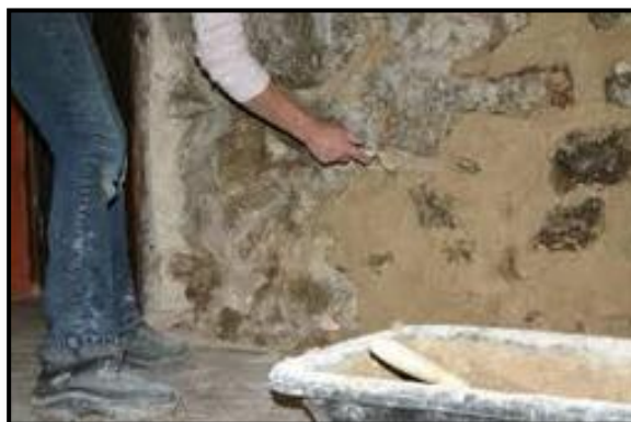
Fig. 2-57 : Rejointoiment du mur
