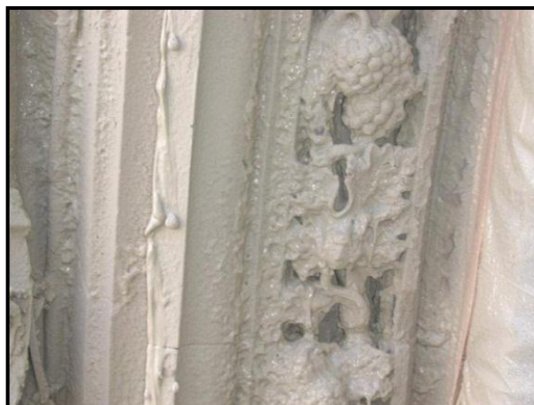
Fig. 2-79 : Pâte de nettoyage 49
