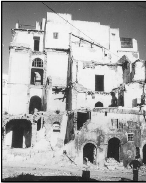
Fig. 1-31 : Avant la restauration LESBET Djaffar (septembre 1983)
