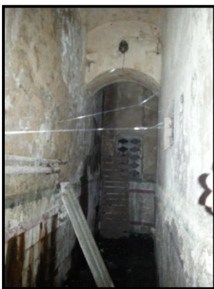
Fig.2-69: Murs saturé en eau auteur du mémoire
