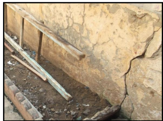
Fig. 2-16 /2-17 : Fissures apparentes sur le mur et l'enduit de hammam Es-Sbaâ auteur du mémoire
