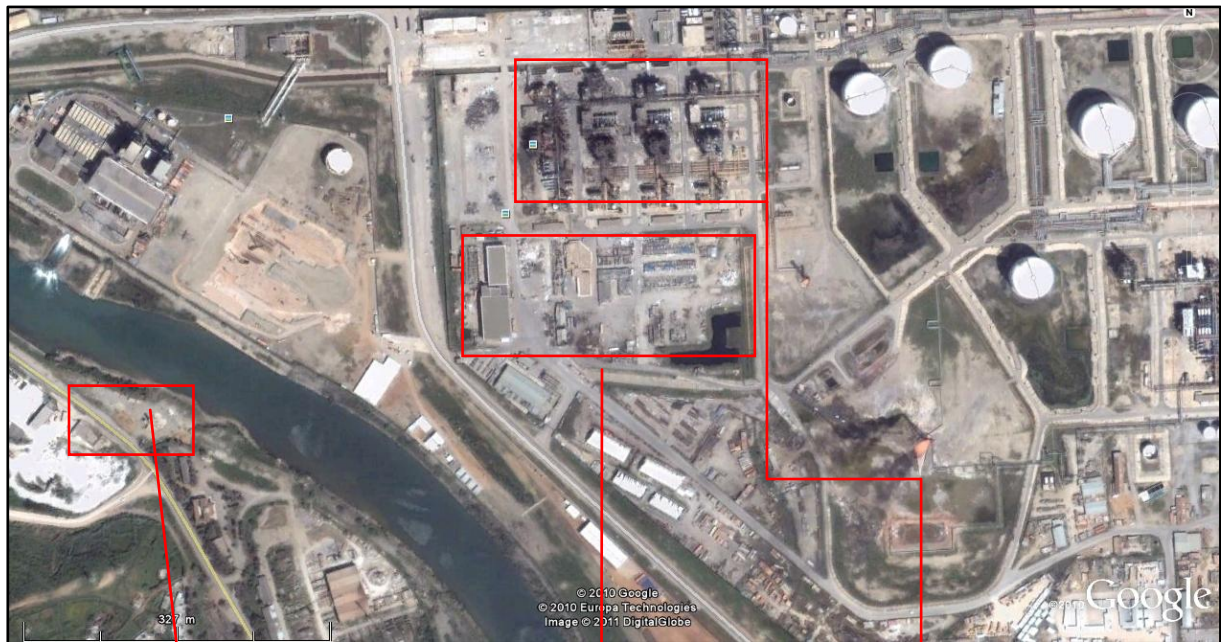
Planche 1 : Site du complexe GL1K après explosion
