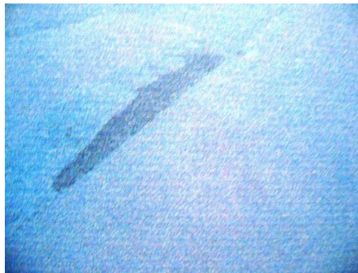
Figure 4.29 : Epaufrure de degrés moyen (bout bétonné N°19)
