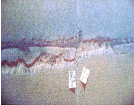
Figure 4.27 : Epaufrure graves (bout bétonné N°01)
