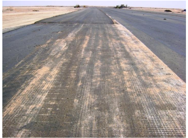
Les travaux de renforcement sont en cours
