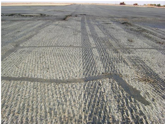
Les travaux de reprofilage en cours
