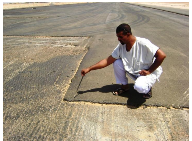
Les travaux sur la piste principale presque achevés
