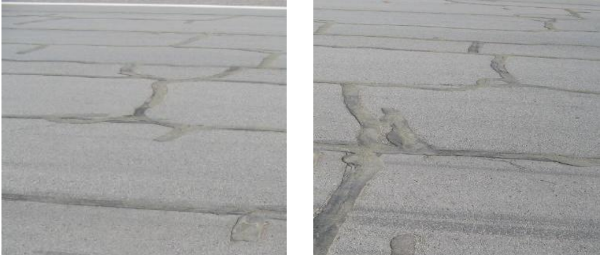
Figure 4.5 : Faïençage de retrait avec un degré moyen
