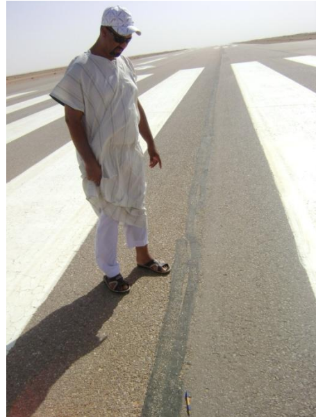
Figure 4.20 : Réparation ponctuelle dégradée
