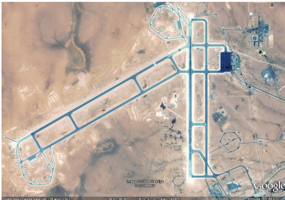
Figure 3.5 : Aéroport de Béchar vue satellite
