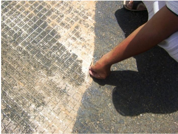
Géotextile utilisée pour le renforcement
