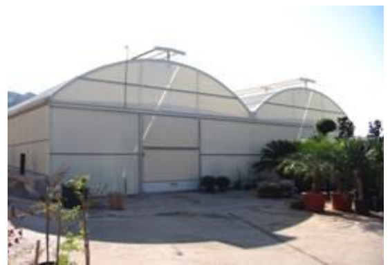
Figure 46. Différents types de portes de serre. Détail de l'ouverture du toit destinée à automatiser les conditions environnementales de la serre et à assurer un système de ventilation interne.
