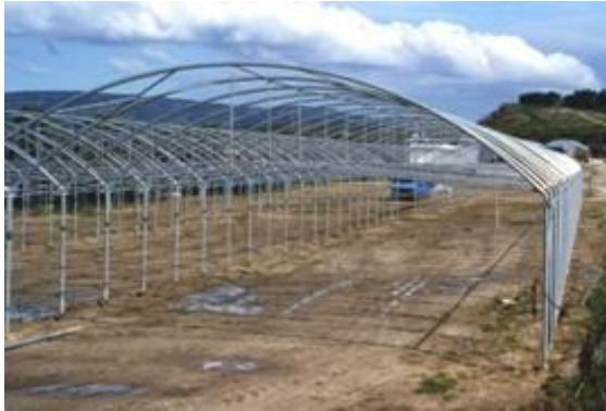
Figure 45. Installation d'une serre (la structure portante est réalisée en fer galvanisé avec des colonnes verticales.
