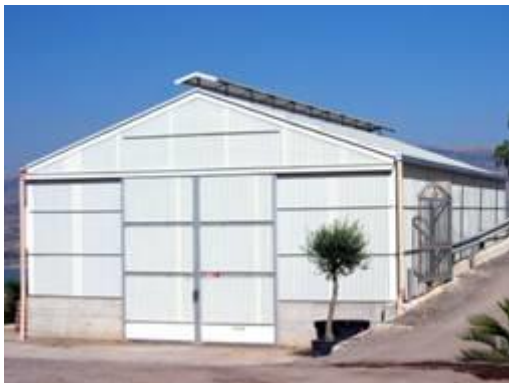
Figure 46. Différents types de portes de serre. Détail de l'ouverture du toit destinée à automatiser les conditions environnementales de la serre et à assurer un système de ventilation interne.
