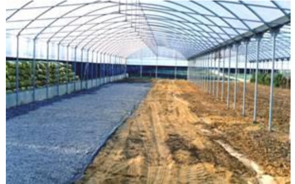
Figure 45. Installation d'une serre (la structure portante est réalisée en fer galvanisé avec des colonnes verticales.
