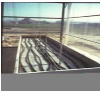
Figure 49. Tubes en polyéthylène pour réchauffer le substrat d'enracinement. Au centre, détail des gicleurs montés sur les barres rigides verticales.
