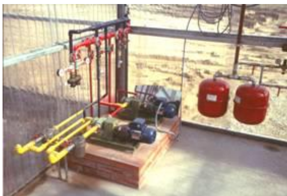
Figure 51. Système de pompes d'alimentation de l'installation de nébulisation. Détail des gicleurs montés sur des barres rigides verticales.
