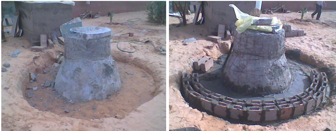
Figure 68. Construction du bac du gazomètre
