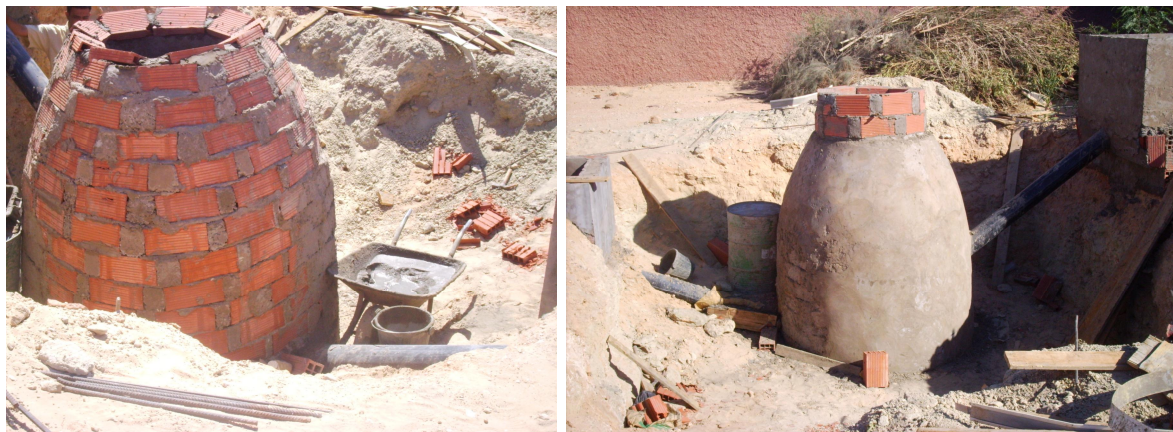
Photo 11. Construction du dôme et trou dôme
