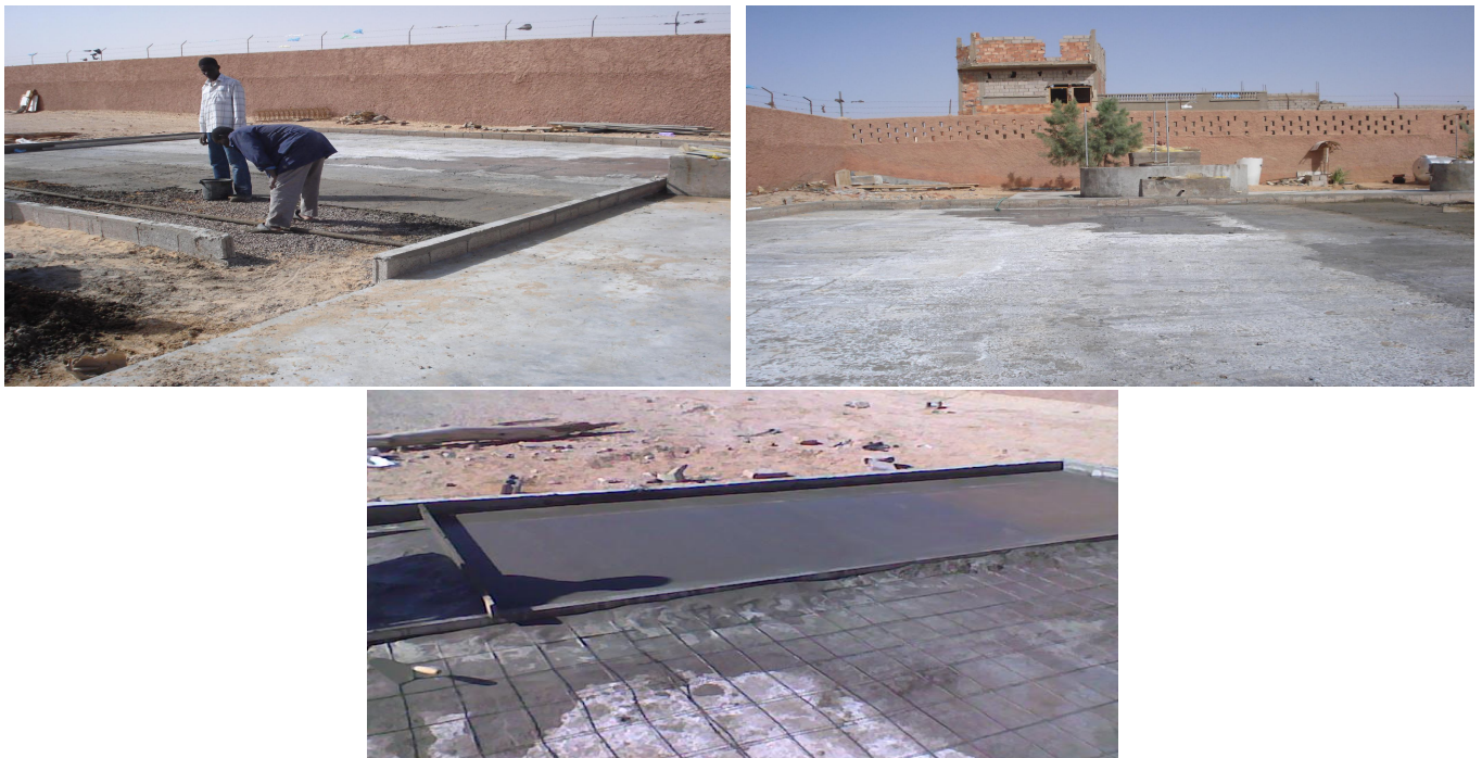
Photo 15. Construction du lit de séchage
