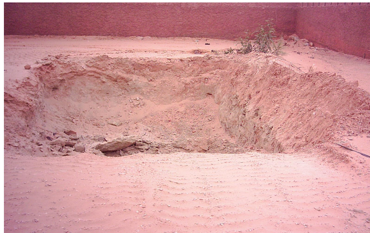
Photo 7. Fosse pour l'implantation du digesteur
