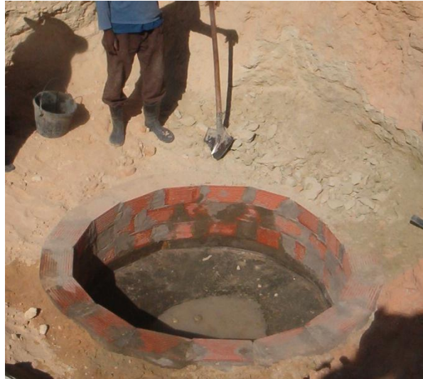
Photo 8. Début de construction du mur de la cuve de digestion
