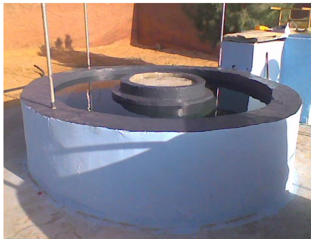
Photo 14. Construction du gazomètre
