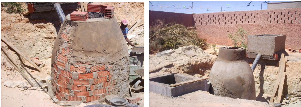
Photo 12. Revêtement du digesteur
