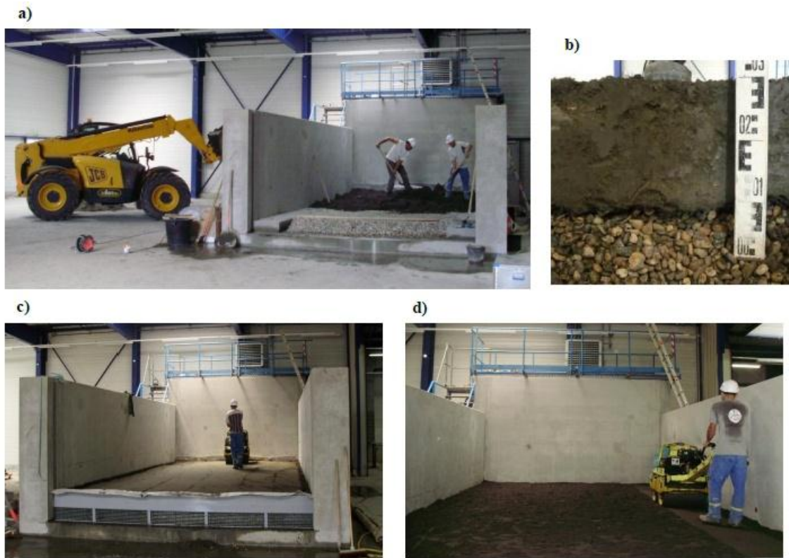
Figure 1.30. Construction d'une digue expérimentale a) Mise en place des matériaux ; b) Interface gravier-limon ; c) et d) Compactage des couches de limons (Béguin, 2011)
