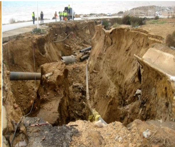
Figure 3.7. Ouverture d'une fosse et destruction des différents réseaux
