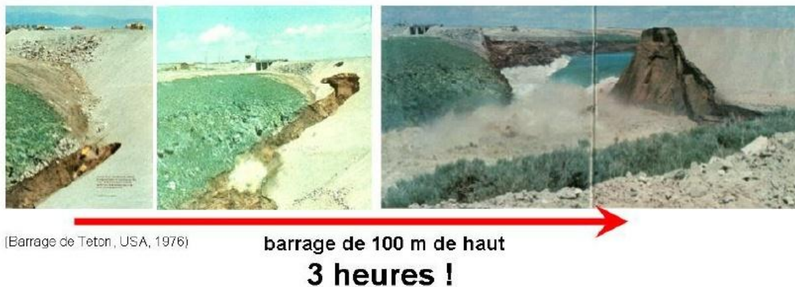
Figure 1.16. Rupture du barrage de Teton (1976) (Lachouette, 2009)
