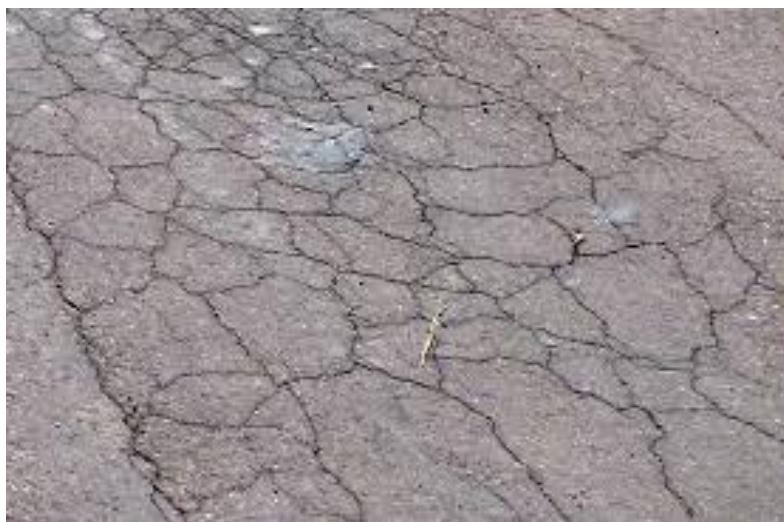
Figure II.10- faiénçage circulaire
