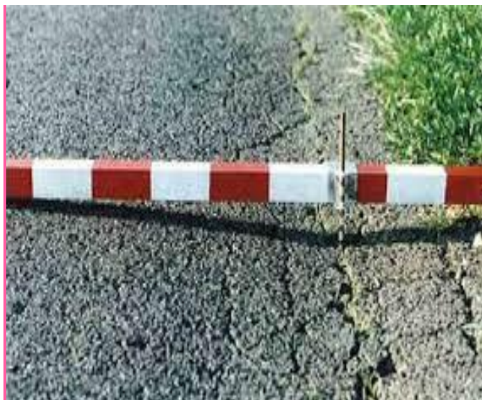
Figure II.5 : Affaissement
