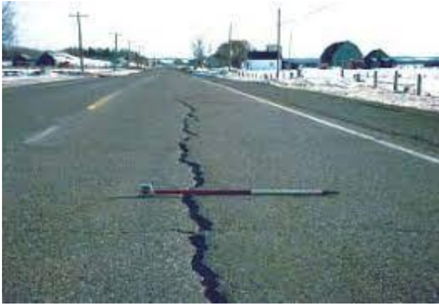
Figure II.13 : Fissure longitudinale
