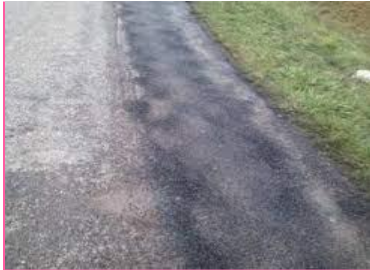
Figure II.3 : Les remontés
