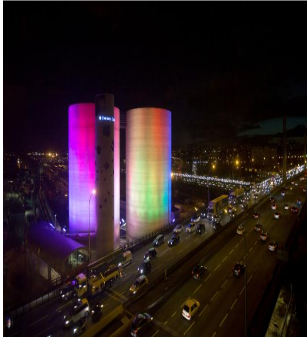
Figure 15 : Une installation lumineuse pérenne prouesse technologique et évocation magnétique. (Source_2016 : ,Batinfo,Ciments Calcia via Schilling Communication)
