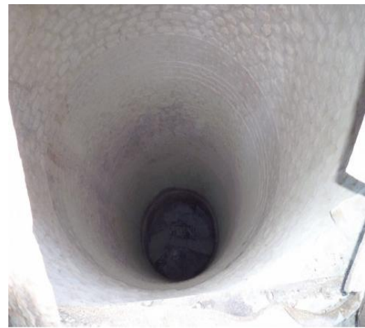
Figure 04 : Intérieur du four à chaux Usine Chenu (26) Aouste sur Sye. (Source_2016, La chronique du musée des Berthalais )
