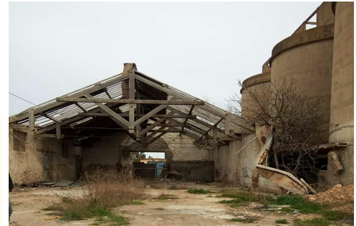
Figure 45: Le hangar avant. (Source_2018 : Auteur)
