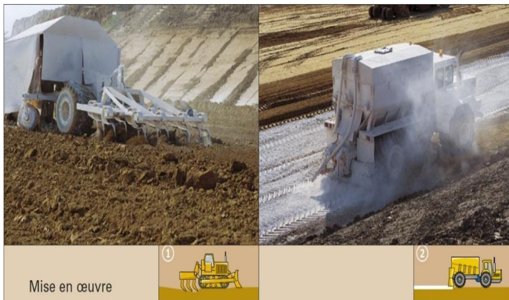
Figure III.10.A : Technique de Malaxage ( fediex section Kalk sectie ).
