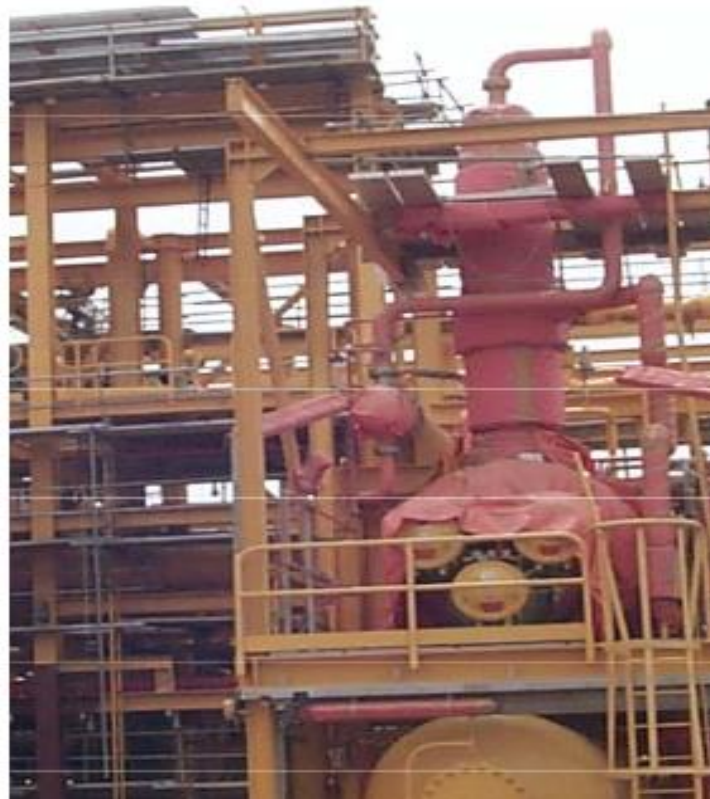
Figure II.8 : Régénérateur de TEG [17]
