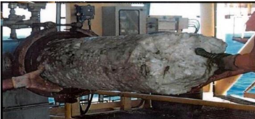
Figure II.3 : Bouchage d'une conduite par le givrage des hydrates [10].
