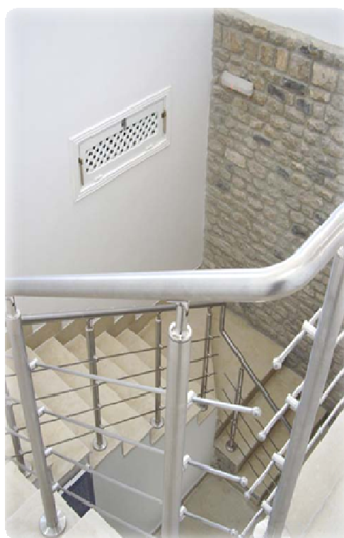
photo 17: Vue sur l'intérieur
