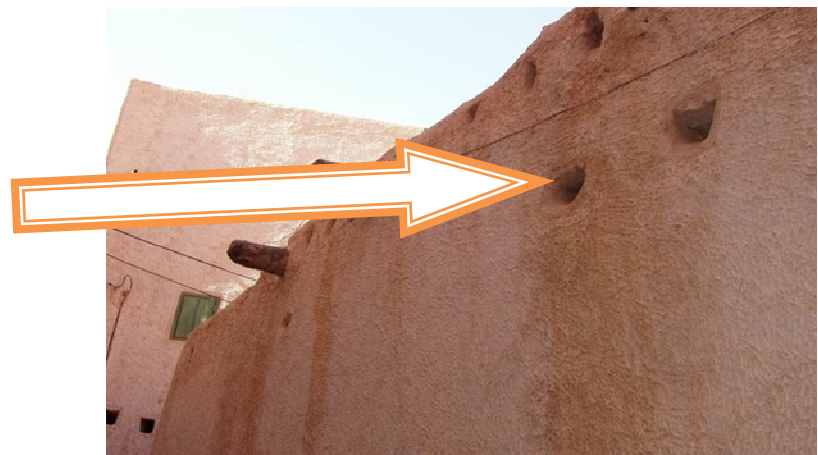
Figure 67: Des percements dans La maçonnerie
