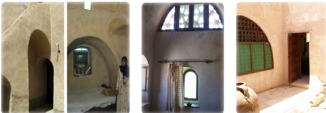
photo48 Cour intérieure photo49 intérieur de maison, photo50 iwan avec voûte mai 2006
