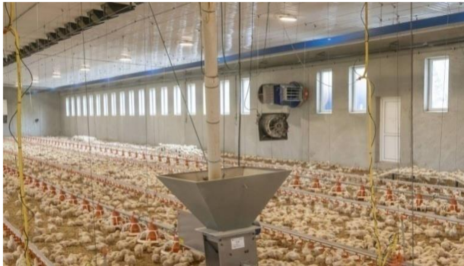
Figure 04 : Bâtiment d'engraissement de poulet de chair avec échangeur de chaleur (Big Dutchman, 2024).
