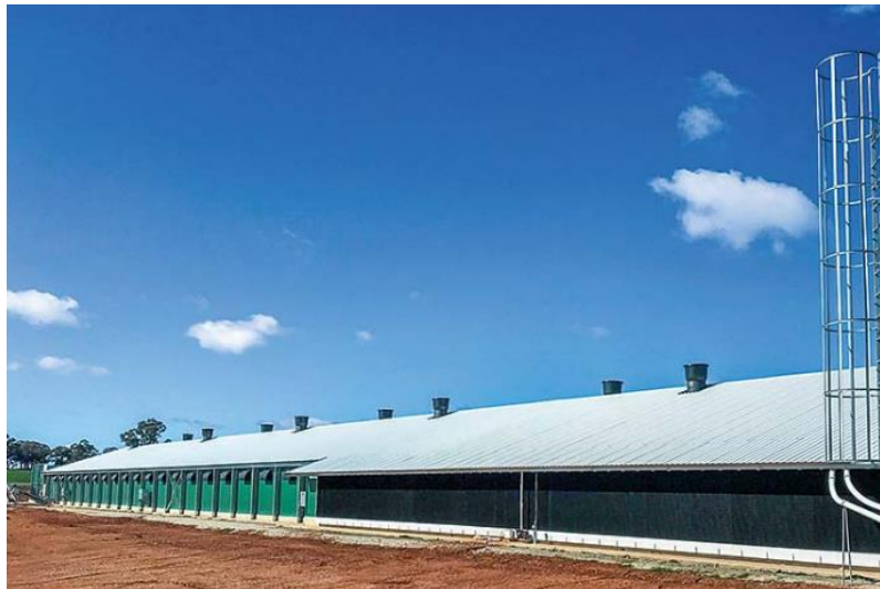
Figure 06 : Bâtiment d'élevage avec la technique Pad Cooling (Big Dutchman, 2024).
