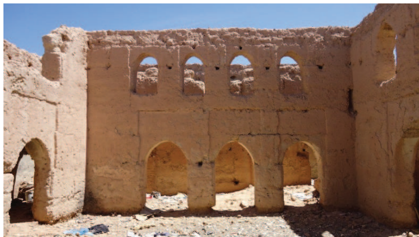
Photo 5.2 : Patio (Rahba) de Dar Eddeymani.
