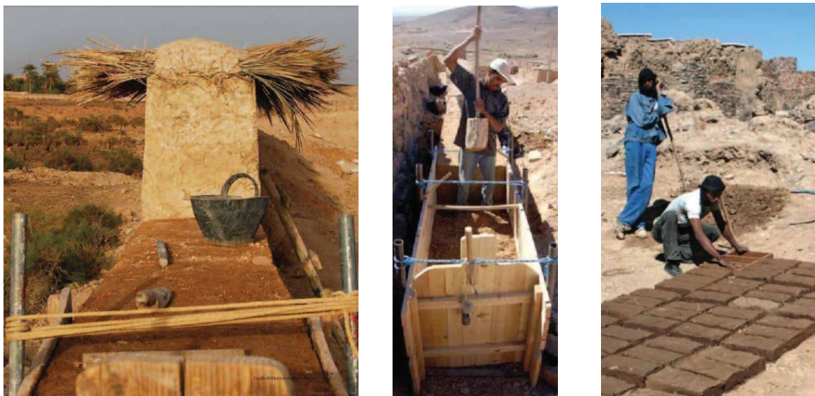
Photo 3.15 : Différentes techniques de construction en terre.
