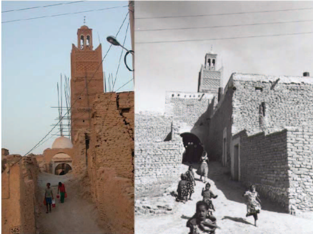
Photo 2.8 : Dégradation du cadre bâti.
