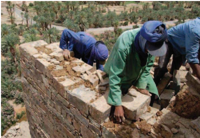
Photo 3.14 : Reconstruction d'un mur en pierre lors de la restauration du ksar.
