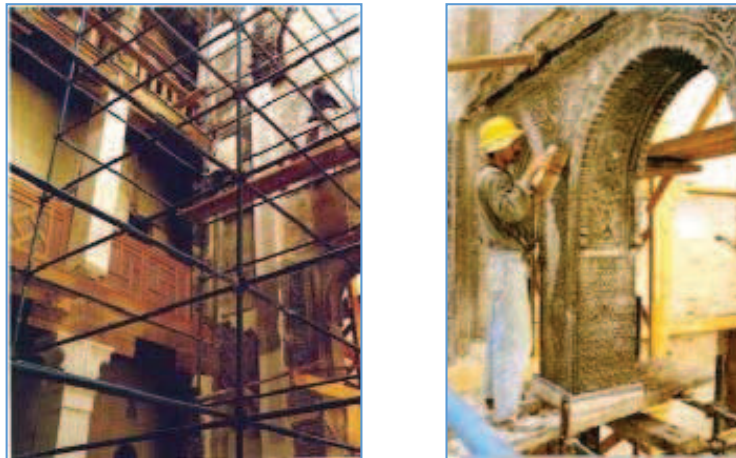
Photo 1.9 : représente les travaux de restauration de la MEDRASA MESBAHIYA. Source : www.aderfes.ma
