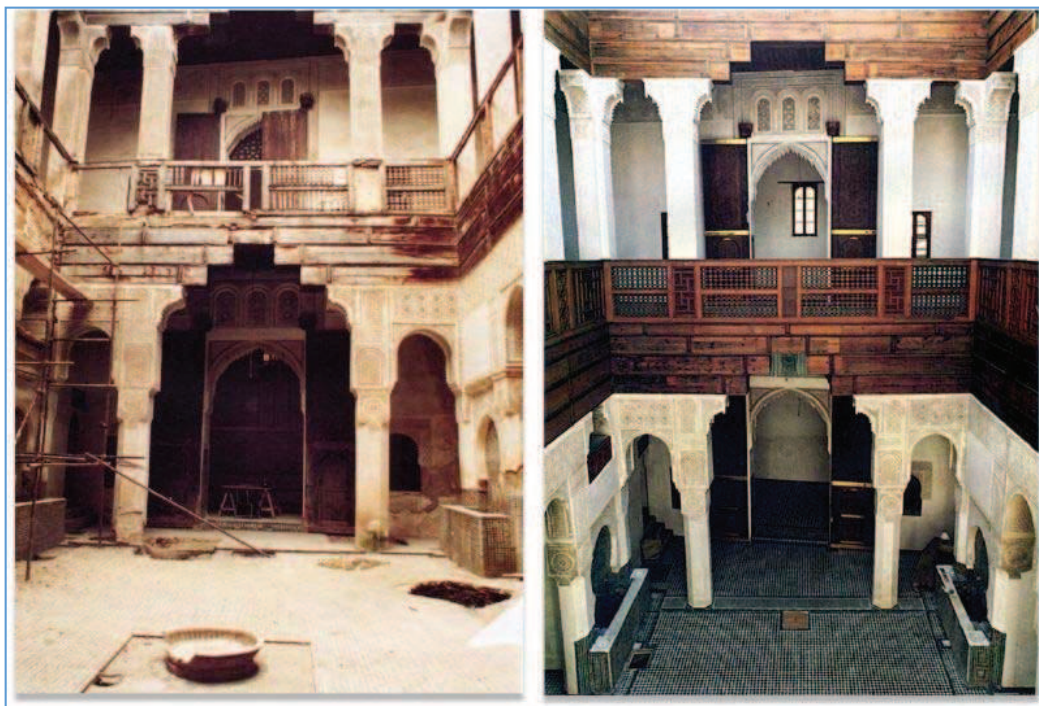
Photo 1.10 : Intérieur du palais Dar Adiyel pendant et après les travaux de restauration 78 .
