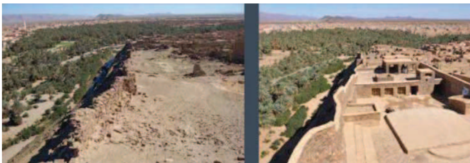
Photo 3.18 : Vue sur le rempart du ksar (avant et après les travaux).
