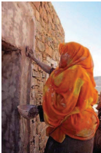
Photo 3.16 : Enduit en terre.
