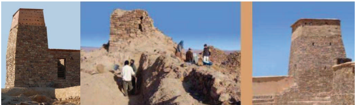
Figure 3.32 : Le Borj Ihchach (avant et après les travaux).
