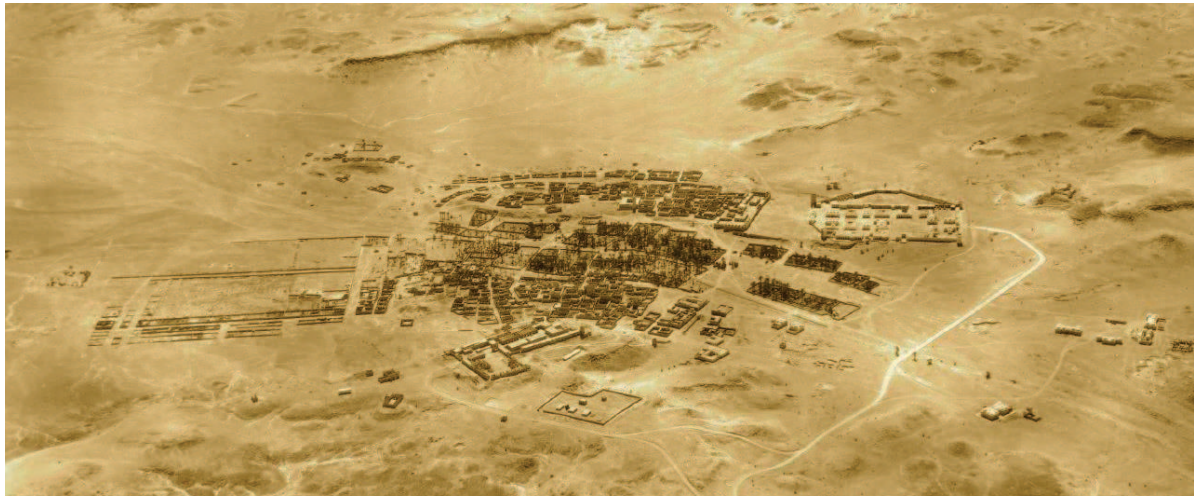
Photo 4.6 : Vue aérienne sur les deux Ksour (R'madhine et Moussānni), environ 1950.
