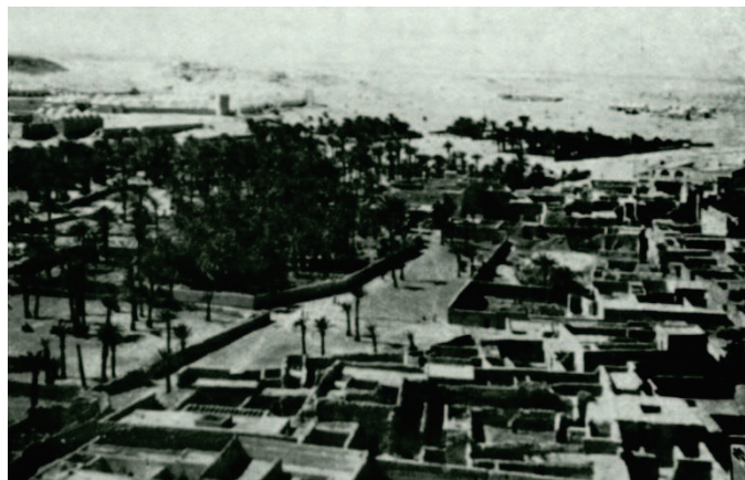
Photo 4.7 : Vue sur une partie du Ksar R'madhine, où montre l'effet de l'ombre sur les masses du bâti. Source : J.Larribaude, 1952.
