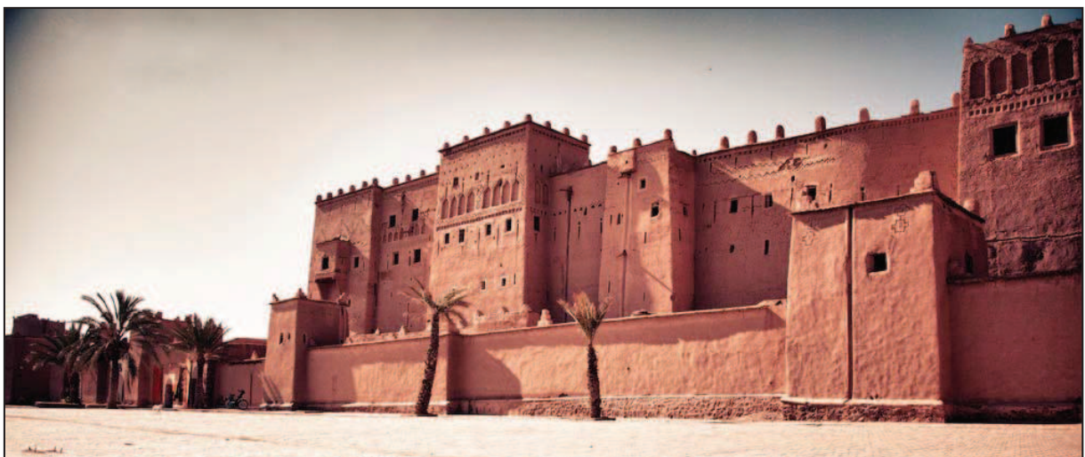
Photo 2.1 : Kasbah de Taourirt, Ouarzazate.
