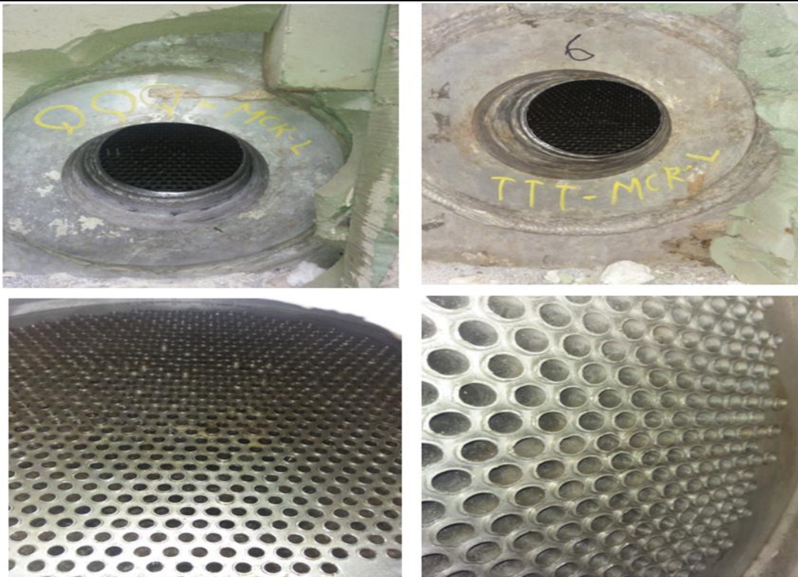
Figure. II.5.Faisceau tubulaire d'un échangeur thermique
