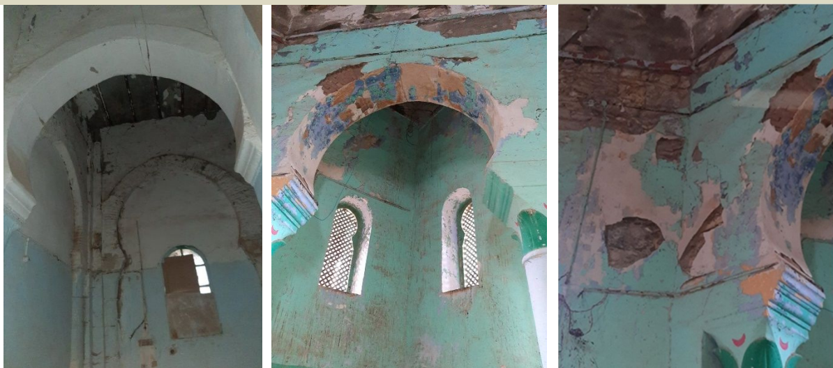
Figure 19 : les arcades intérieures
