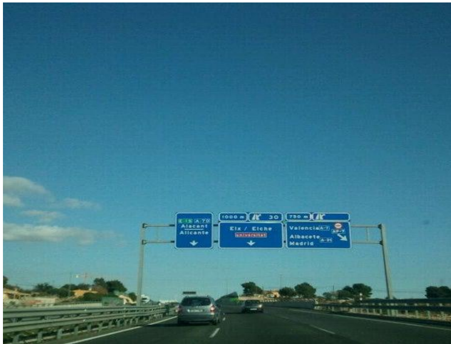
Figure n°1 : La Rocade Alicante.
