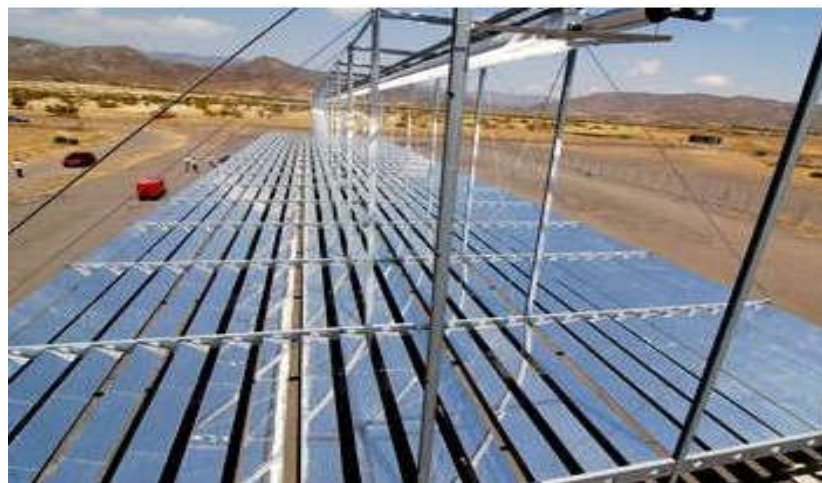
Figure I-4 : Miroirs de Fresnel
