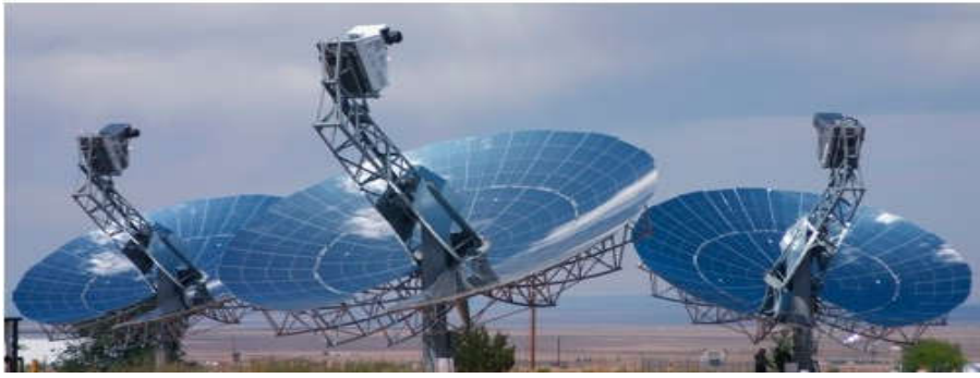
Figure I-8 : Centrale à miroirs Dish-Stirling
