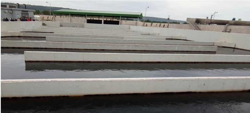
Photo N°8 : Désinfection (photo prise à la station)
