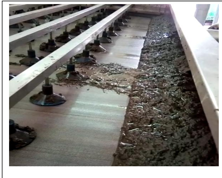
Photo N°10: Épaississement (photo prise à la station)
