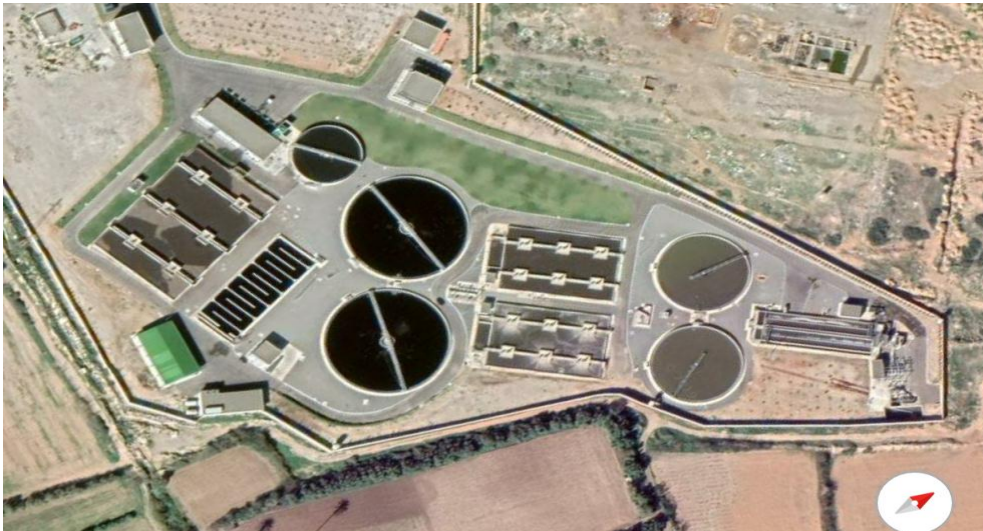
Photo N°1: Carte de localisation de la station d'épuration des eaux usée de Mostaganem
