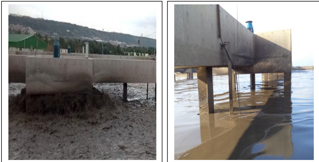
Photo N°9 : Bassin de stabilisation (photo prise à la station)
