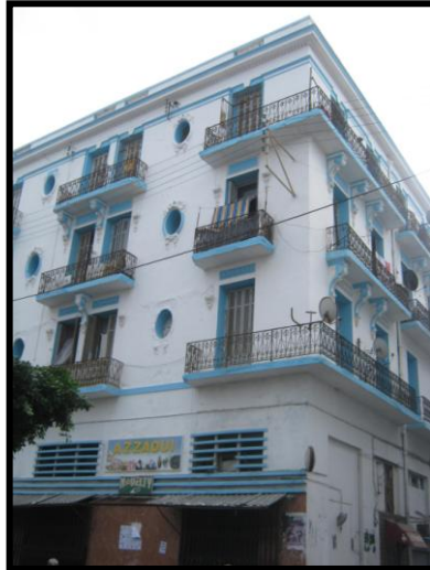
Photo 3.18 Vue de l'immeuble d'habitation N°2.
