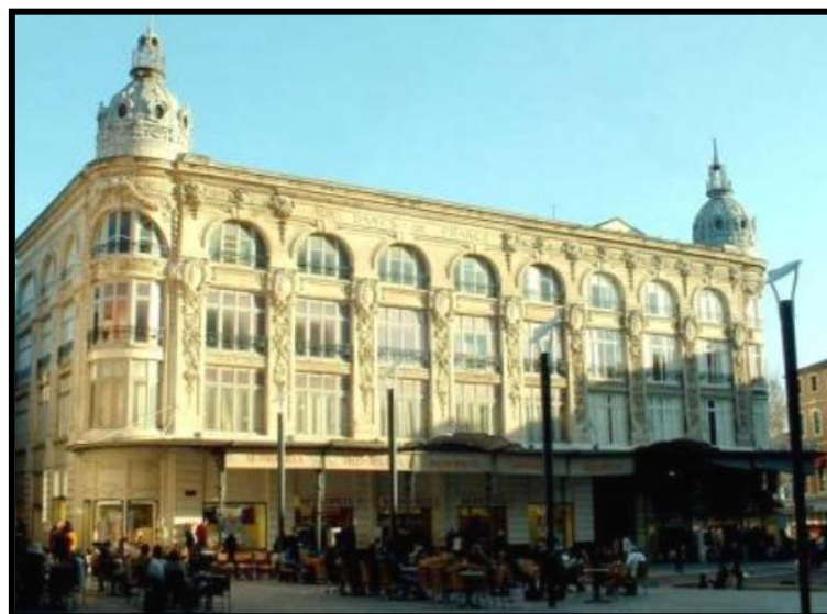
Photo 1.12 Façade principale de Monoprix de Narbonne [Restauration d'ornementation, 2009]
