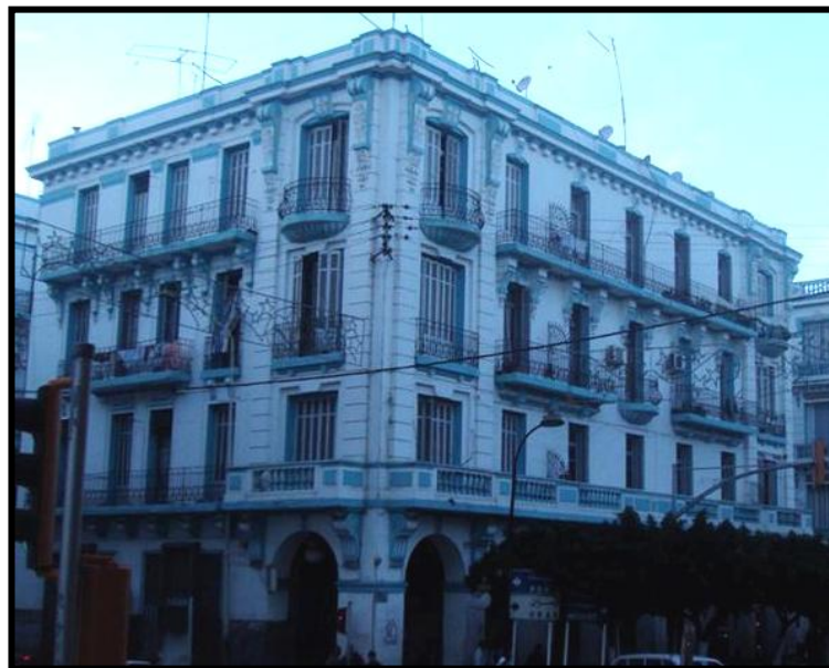
Photo 3.14 Vue de l'immeuble d'habitation N°1
