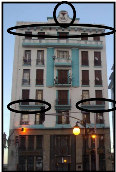
Photo 3.5 Nombre des ornements de la façade de BNCI
