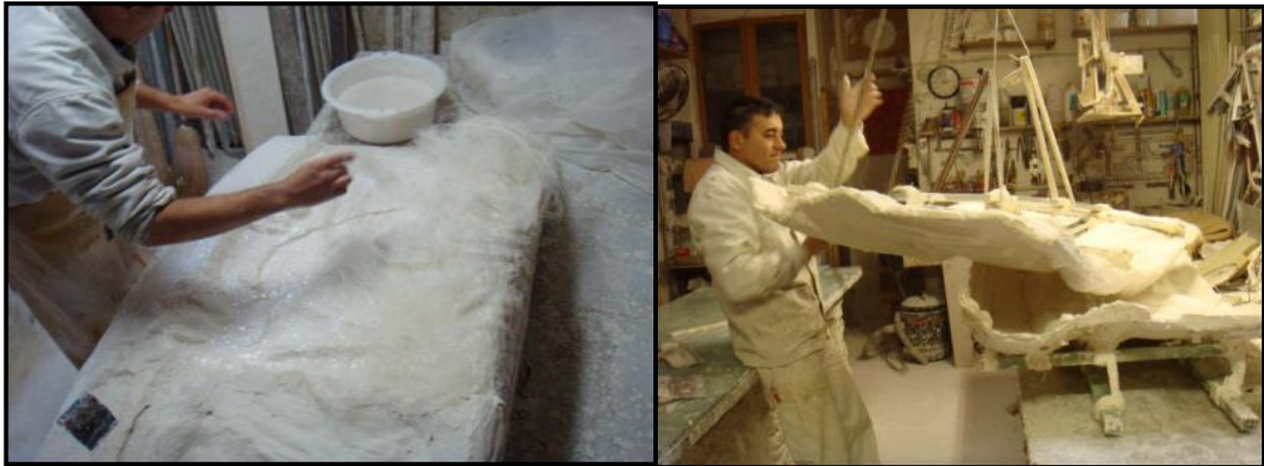
Photo 1.15 Moulage et démoulage de l'ornement architectural
