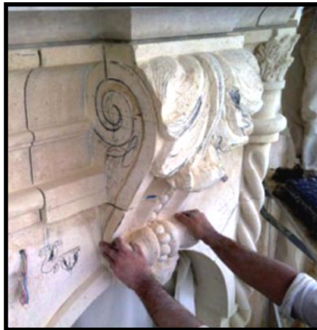
Photo 1.11 Relevé d'ornementation en pierre [Restauration auvergnats, 2012]
