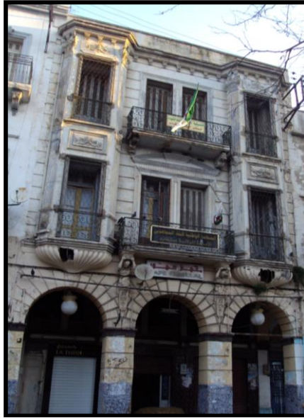
Photo 3.23 Vue de la façade de l'immeuble d'habitation N°3.
