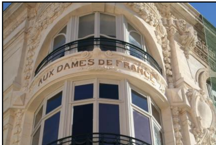
Photo 1.16 Partie finale de l'ornement architectural après la restauration
