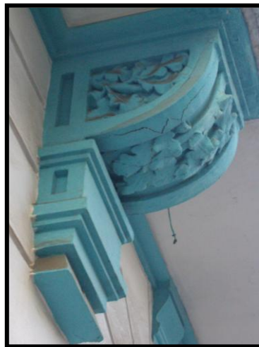
Photo 3.9 Ornement de taille moyenne : Corbeau sous le balcon filant
