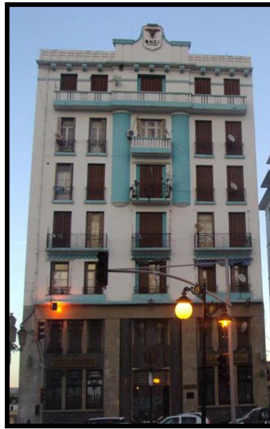
Photo 3.4 Vue de l'immeuble du Banque nationale pour le commerce et l'industrie
