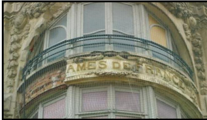
Photo 1.13 Détail de l'ornement architectural avant la restauration [Restauration d'ornementation, 2009]
