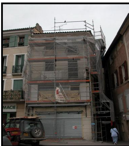
Photo 1.17 Façade l'immeuble a une corniche ionique [Les ateliers du paysage, 2010]
