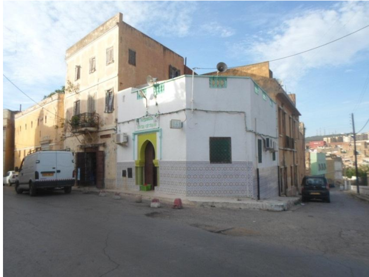
Figure 4.7: vue sur la mosquée Sidi Yahia source : hauteur du mémoire
