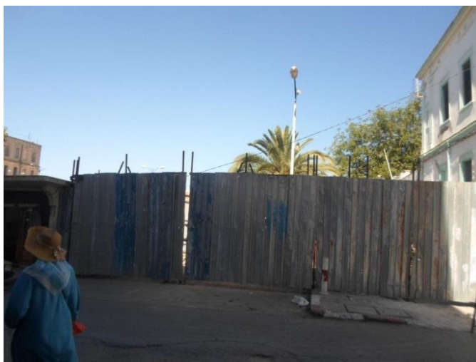
Figure 4.8 : l'emplacement du parking source : hauteur du mémoire
