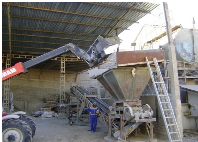
Figure N° 06 : Chargement de la trémie d'al
