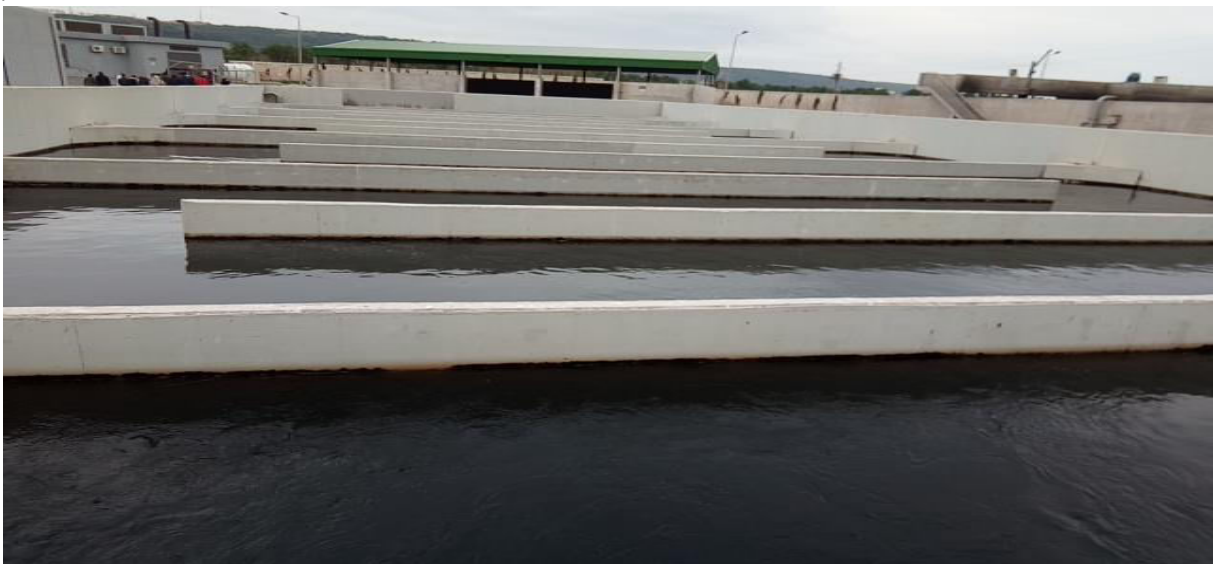
Figure II.8: Bassin de désinfection
