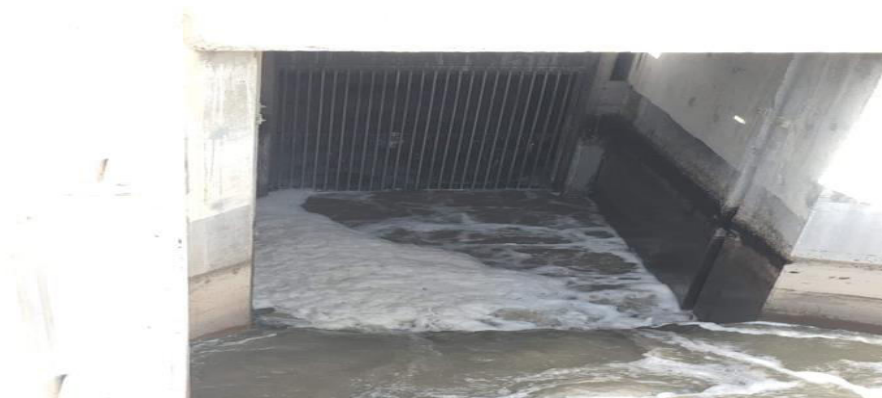
Figure II.4 : Dégrilleur grossier
