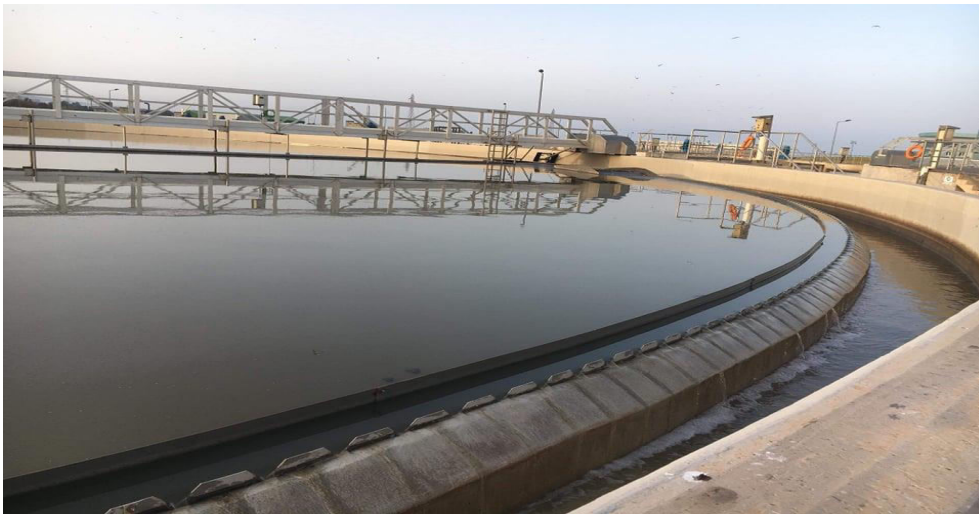
Figure II.5: Décanteur primaire
