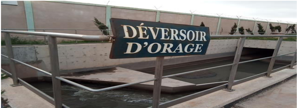
Figure II.3: Déversoir D'orage
