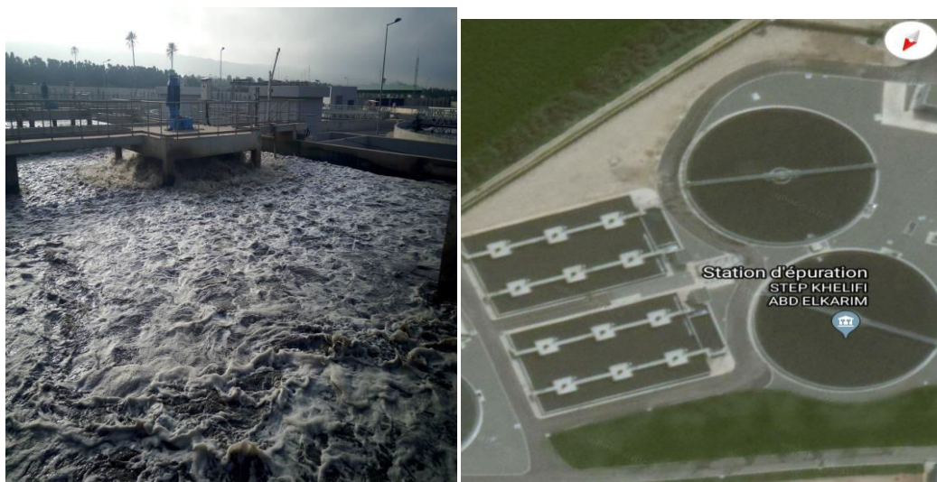
Figure II.6: Bassin biologique (Bassin d'aération)
