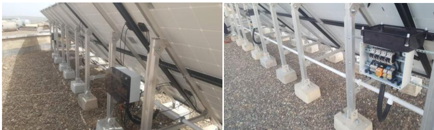
Figure 3.5 : Les boîtes de jonction.
