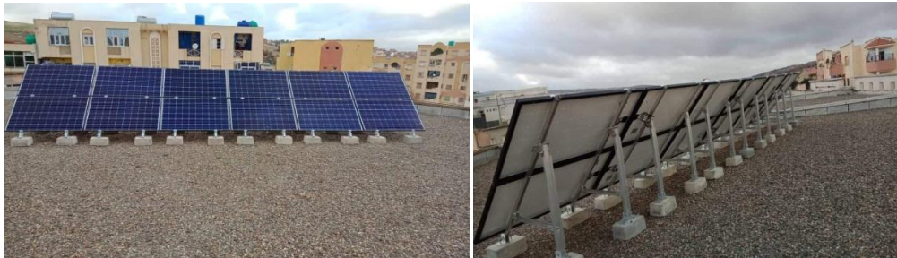
Figure 3.4 : L'installation de panneaux photovoltaïques dans l'école (Abid Habib).
