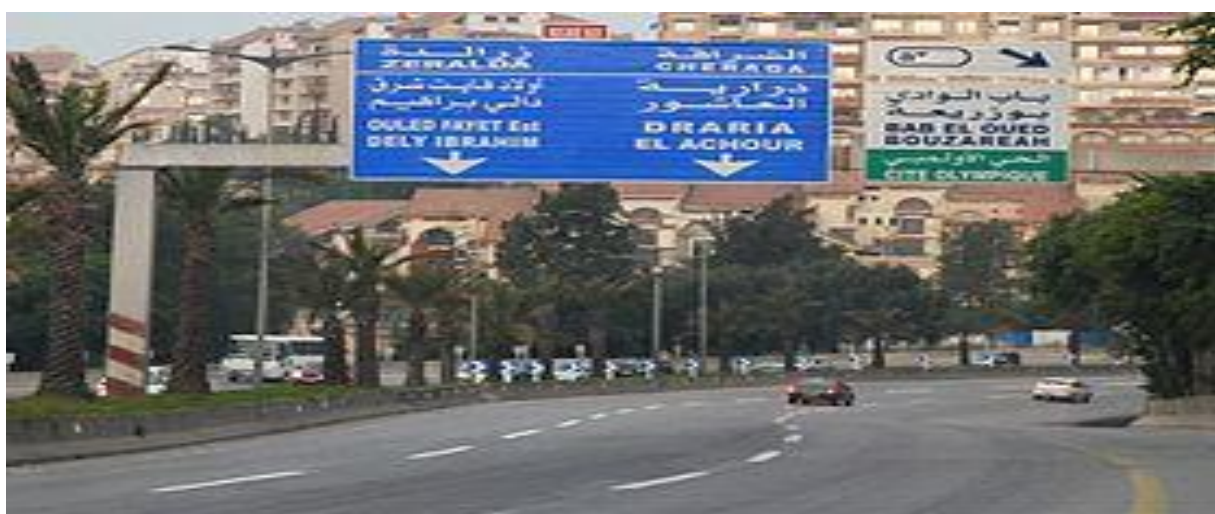
Figure I) II.4 : 2e Rcade sud d'Alger Ouverture du tronçon Birtouta - Khemis El-Khechna
