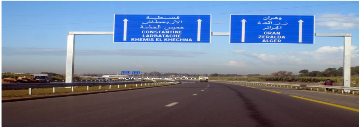
Figure I) II.5 : Réseau routier- balade sur la 2e rocade sud d'Alger
