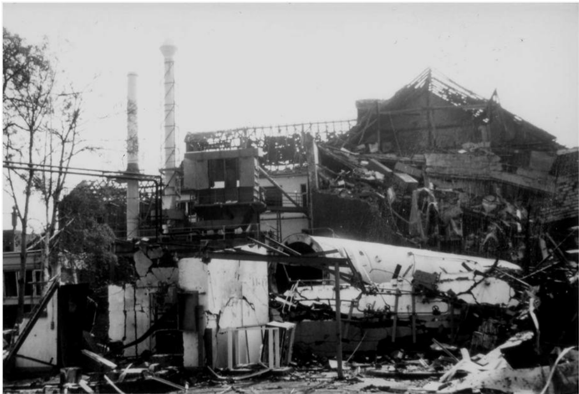
Figure III-1 : Usine après la rupture et l'explosion d'un réservoir de stockage pour l'hydrogène [28].
