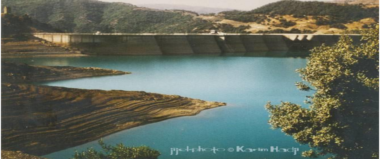
Figure N° I.5 : Barrage Guenitra dans la wilaya de Skikda
