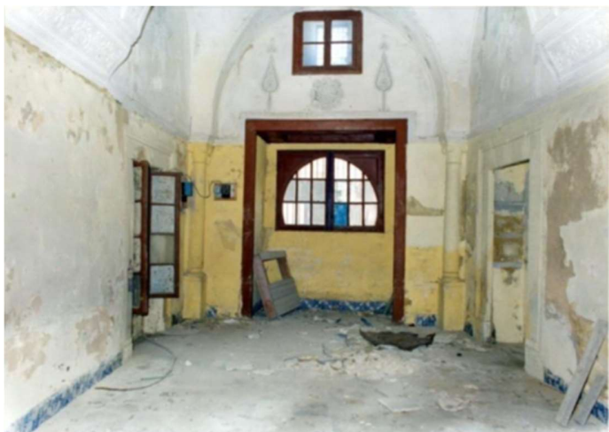
Figure 25 : Palais de Khair-Eddine avant la restauration Source : A.S.M
