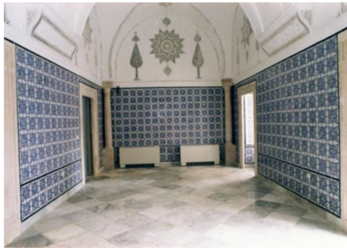
Figure 26 : Palais de Khair-Eddine après la restauration Source : A.S.M
