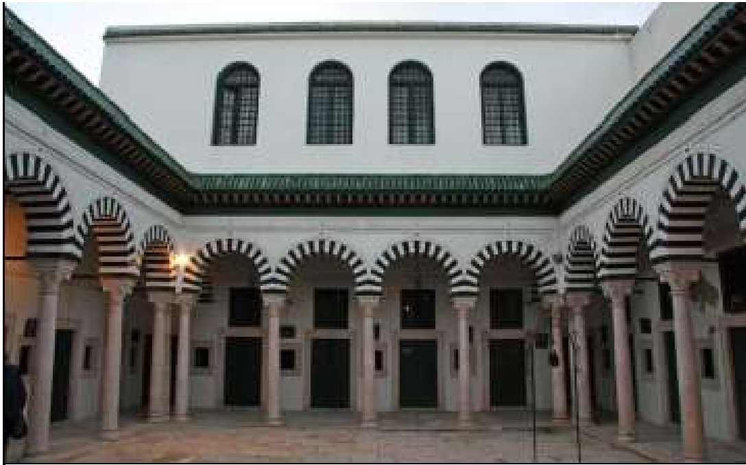
Figure 29: Zaouïa Sidi Ibrahim Riahi. Source : Wikipédia
