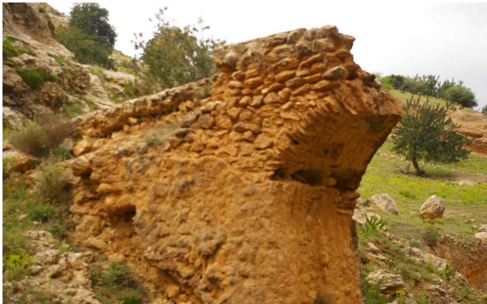
Figure 46 : Vestige d'une Passerelle à Mesrata (Gantra de Sid Ahmed Ben-Youcef) Source : Auteur
