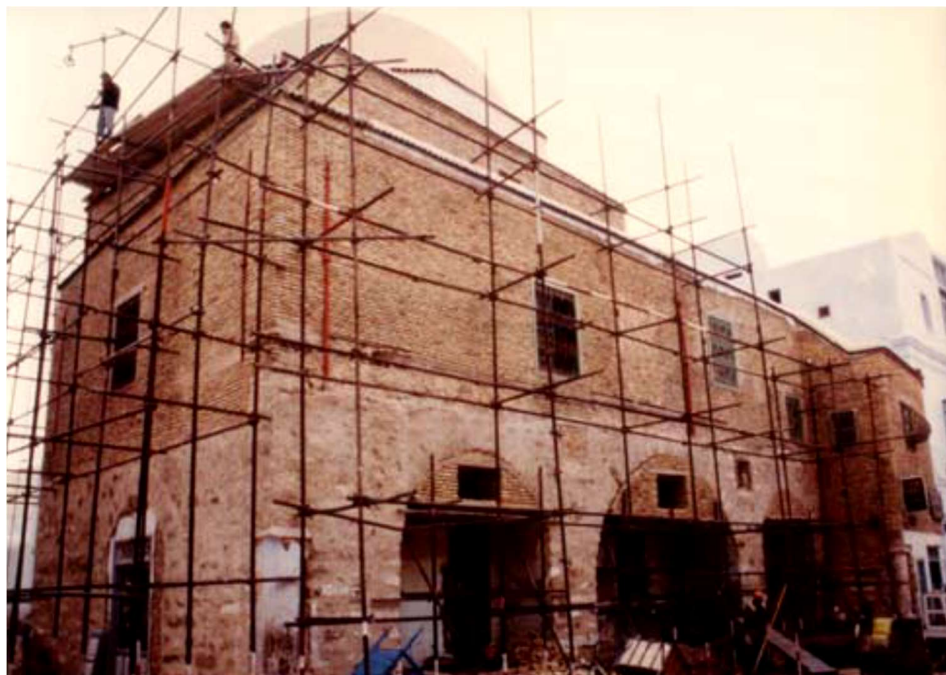
Figure 15 : Puits Barrouta en cours de restauration. Source : Photographs of Kairouan Rehabilitation program
