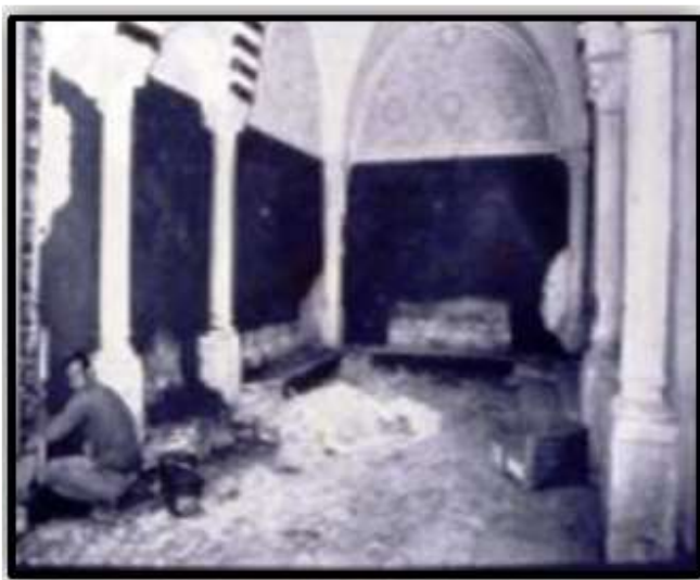
Figure 24 : Dar Larsam avant la restauration Source : L'A.S.M
