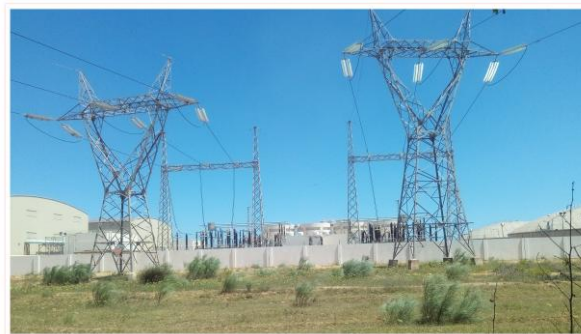
(b) station de dessalement de l'eau de mer MAO
